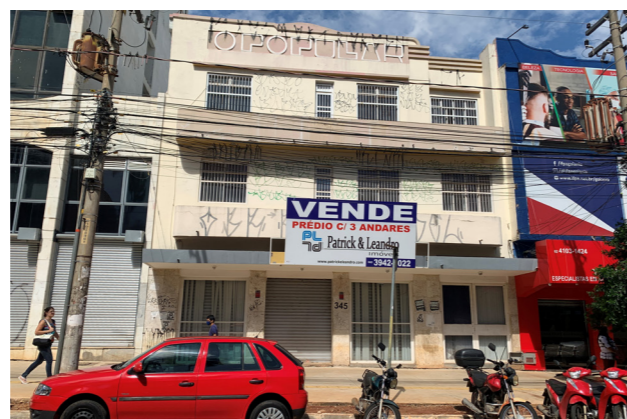
Figura 70: fachada edifício O Popular. Fonte: acervo pessoal, 2022.
