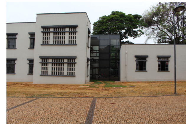
Figura 151: fachada oeste. Fonte: acervo pessoal, 2022.
