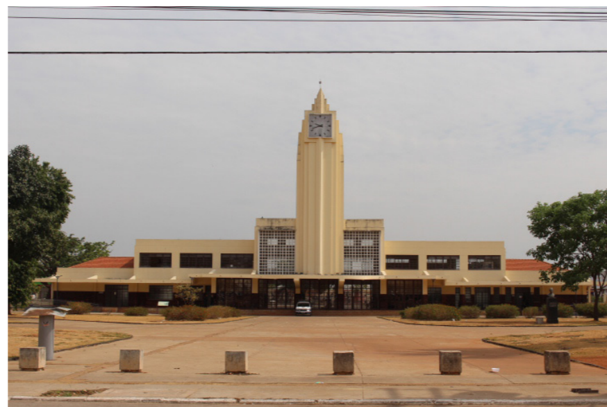
Figura 18: Estação Ferroviária (2). Fonte: acervo pessoal, 2022.
