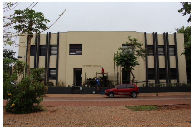
Figura 147: fachada norte. Fonte: acervo pessoal, 2022.
