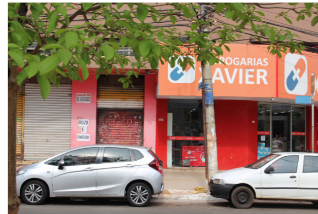
Figura 39: edificação com fachada oculta por letreiro. Fonte: acervo pessoal, 2022.
