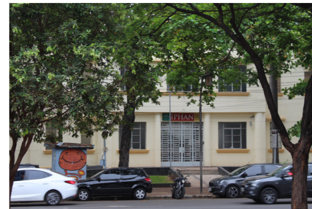
Figura 122: acesso hall de entrada. Fonte: acervo pessoal, 2022.
