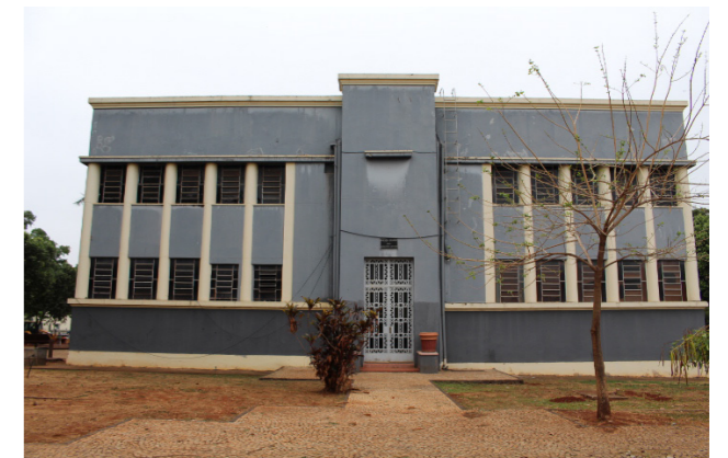
Figura 131: fachada sul. Fonte: acervo pessoal, 2022.
