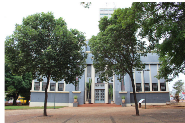
Figura 128: fachada oeste. Fonte: acervo pessoal, 2022.
