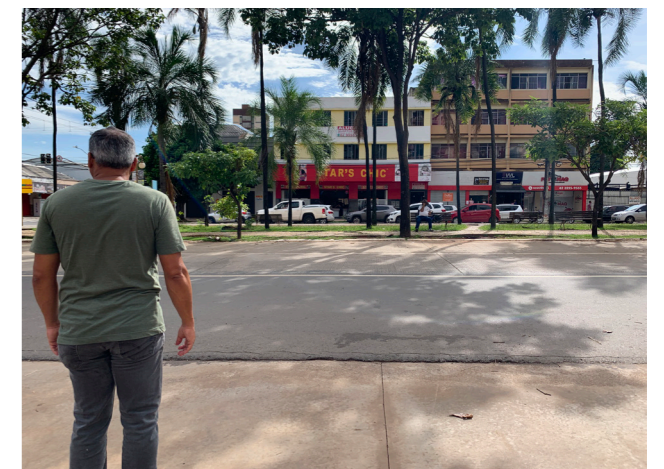
Figura 42: edificações com fachada oculta por letreiro. Fonte: acervo pessoal, 2022.
