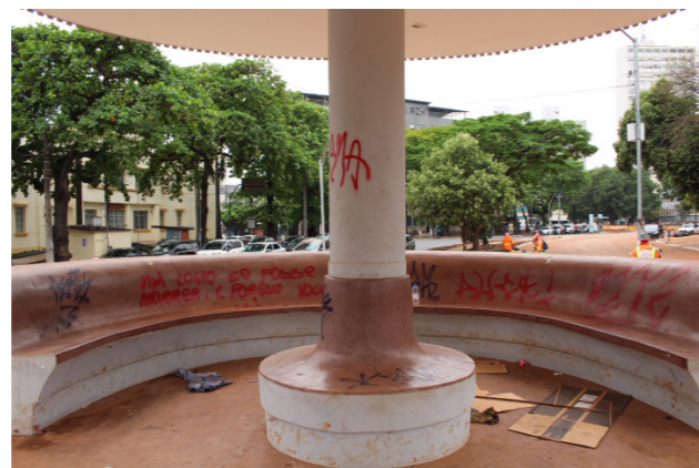
Figura 101: banco interno pichado. Fonte: acervo pessoal, 2022.
