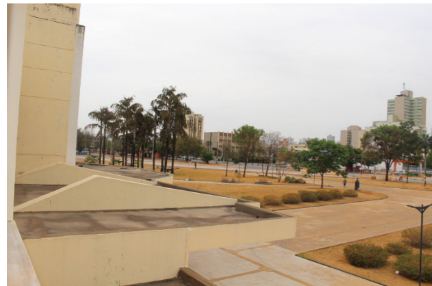
Figura 58: antiga Estação Ferroviária e sua praça (vista 3).
