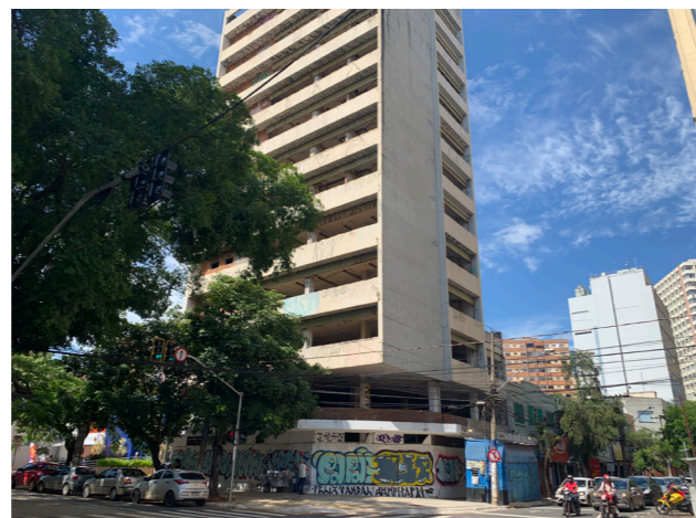
Figura 36: edifício subutilizado. Fonte: acervo pessoal, 2022.
