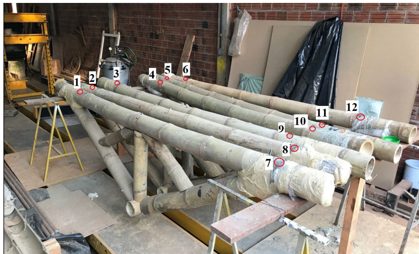
Figura 4: Concretagem dos apoios das tesouras. Fonte: autores.
