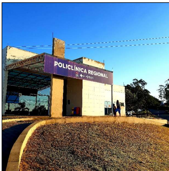
Figura 6. Policlínica Regional de Araranguá
