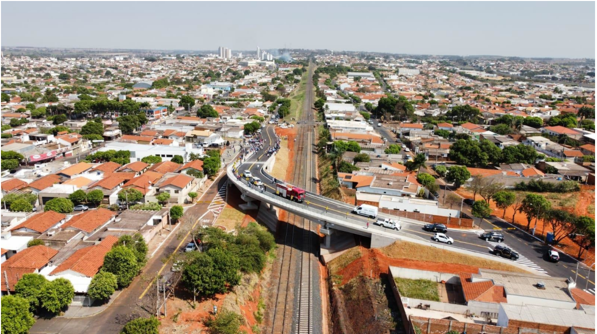
Figura 22 - Viaduto no município de Jales (SP)
