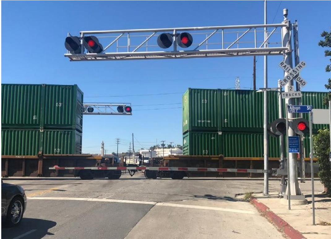
Figura 30 - Exemplo ilustrativo de dispositivo de luz intermitente suspenso em balanço
