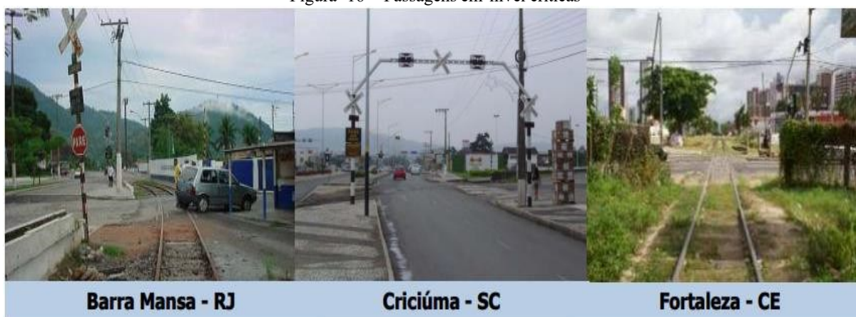
Figura 16 - Passagens em nível críticas
