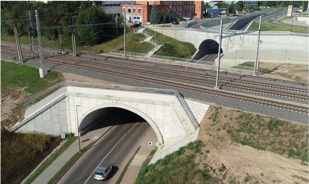
Figura 23 - Travessia subterrânea instalada em Caunas
