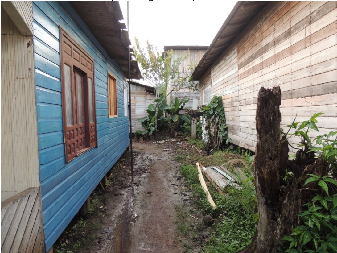
Figura 16 – Lateral da casa após a segunda etapa na reforma, maio de 2022.
