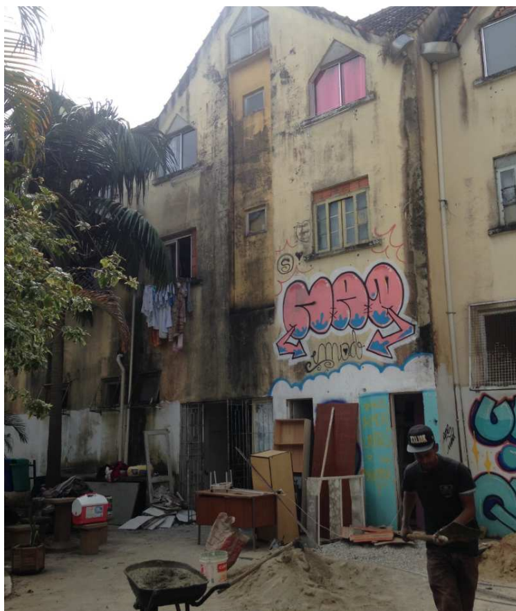
Figura 30 - Edificação do Carandiru com problemas estruturais
