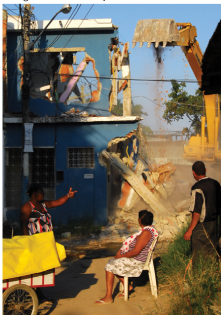
Figura 10 - Demolições na Vila Autódromo
