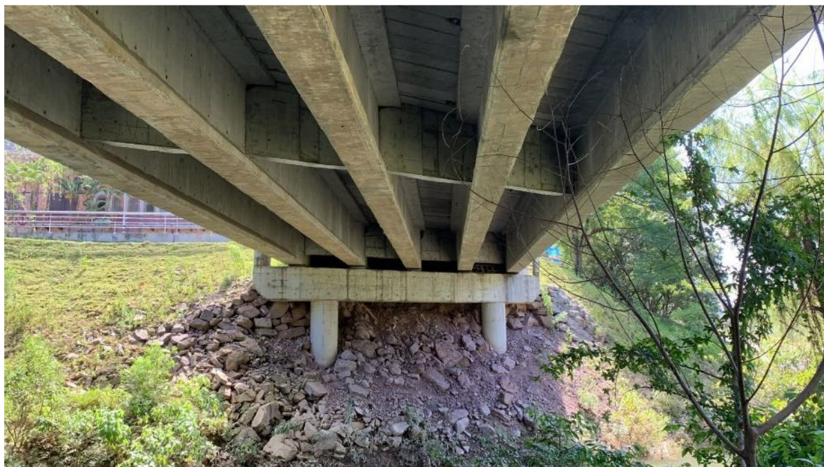
Figura 48 – Ponte 01 - Vão longitudinal ponte Ruy Eduardo Willecke
