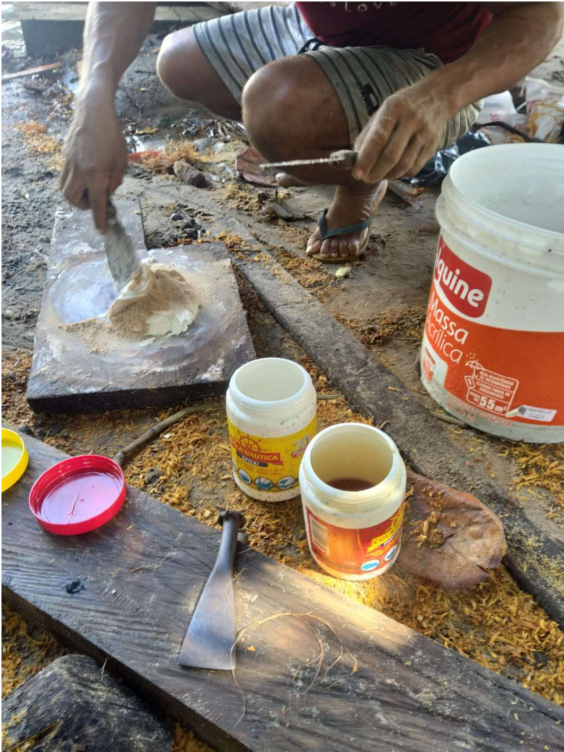
Figura 18 Preparo da cola com as espátulas, cola epóxi, massa acrílica e serragem.
