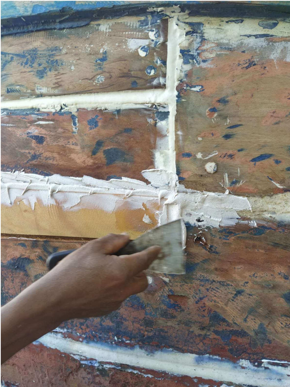
Figura 19 Aplicação da base de cola com a espátula.
