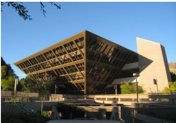
Figura 25. Edifício com auto sombreamento.
