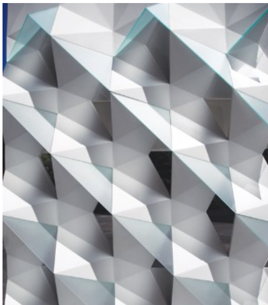
Figura 33. Sombreamento complexo com variação de opacidade e refletância. Protótipo para o Kuwait University College of Education parte para o master plan do Sabah Al-Salem University City no Kuwait. Fonte: Aksamija (2013).
