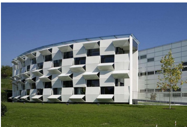
Figura 27. Edifício com elemento de sombreamento externo retrátil.
