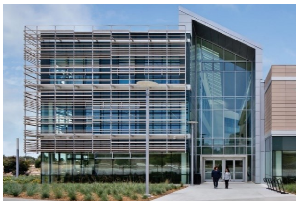
Figura 28. Edifício com elementos externos fixo de sombreamento.
