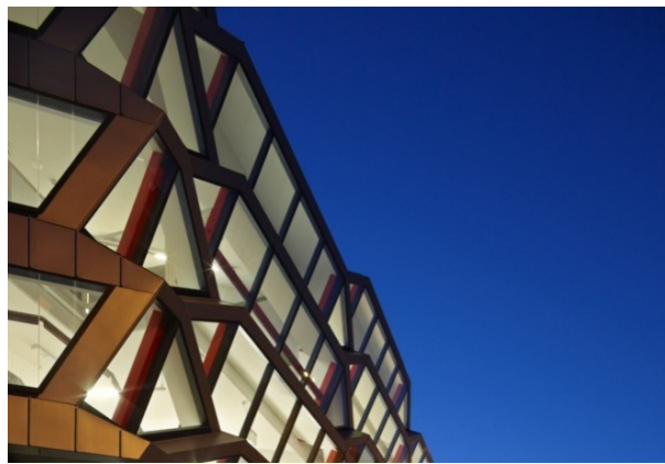
Figura 26. Edifício com auto sombreamento.
