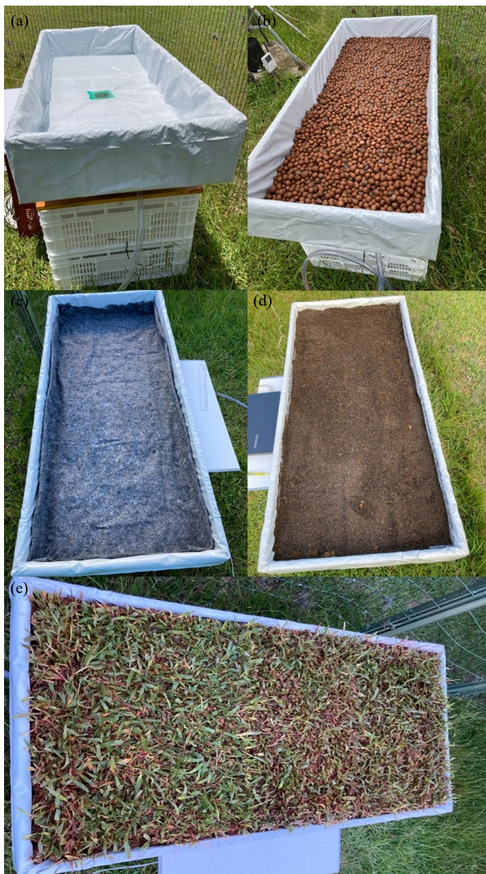
Figura 27 - Registros fotográficos da montagem das camadas do módulo
