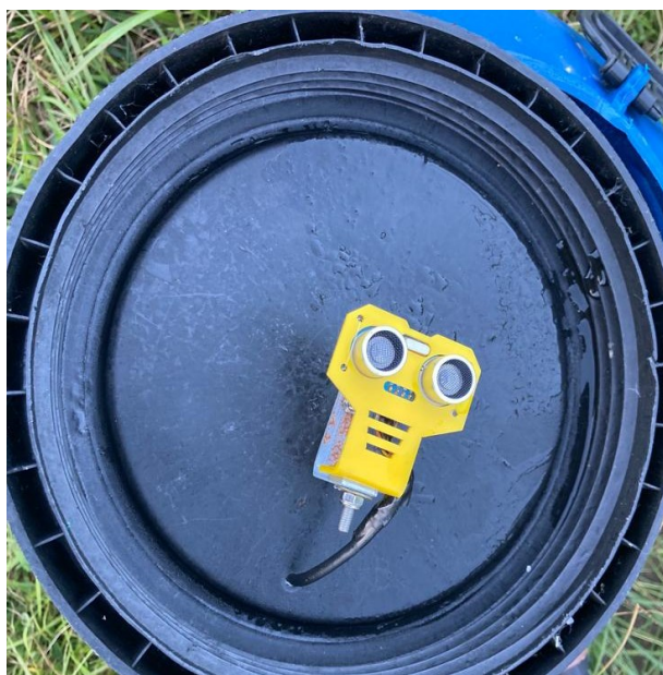
Figura 39 - Condensação na tampa do reservatório do volume escoado pelo dreno
