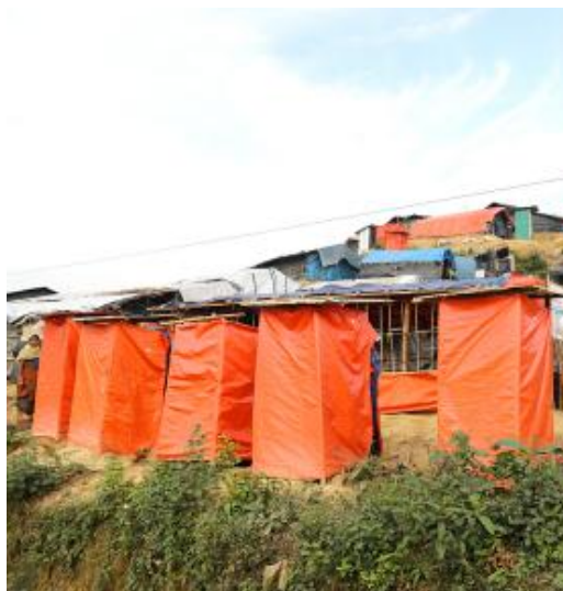
Figura 38: Exterior de latrinas improvisadas.
