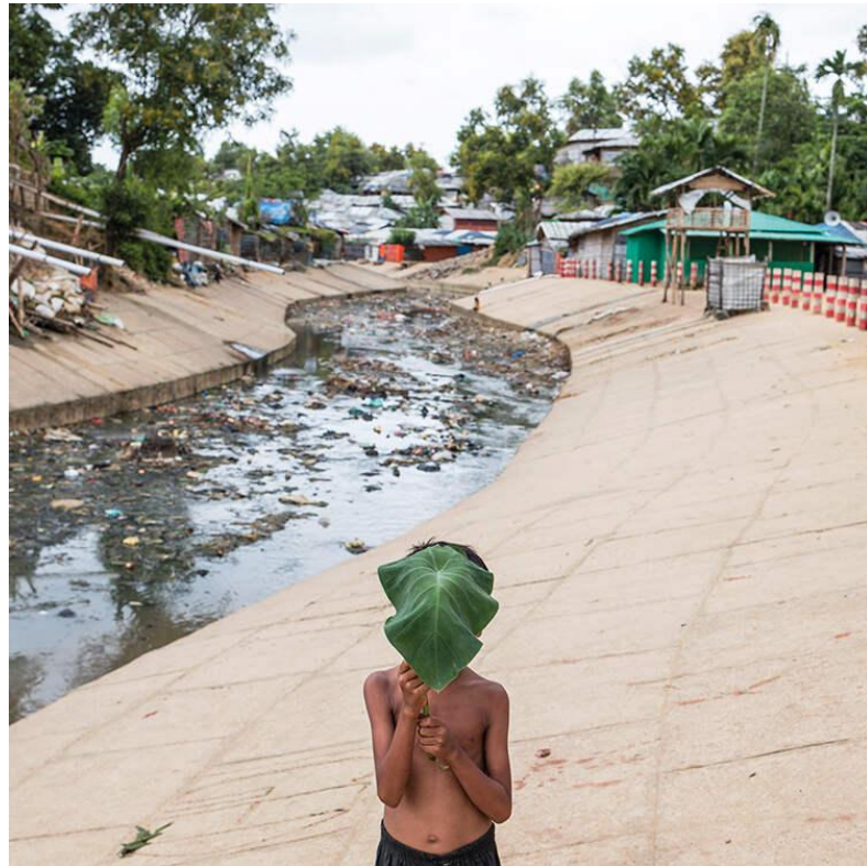
Figura 32: Dreno aberto presente no acampamento de Kutupalong.
