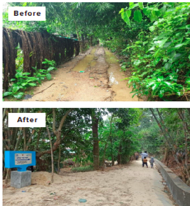
Figura 30: Melhoria da estrada Foliya Para, Localizada em Ukhiya, na entrada do mega campo de Kutupalong.
