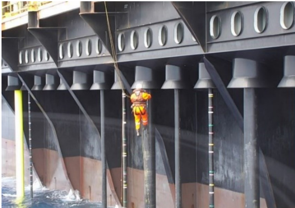
Figura 1 - Inspeção periódica com escaladores industriais na seção emergente dos risers .
