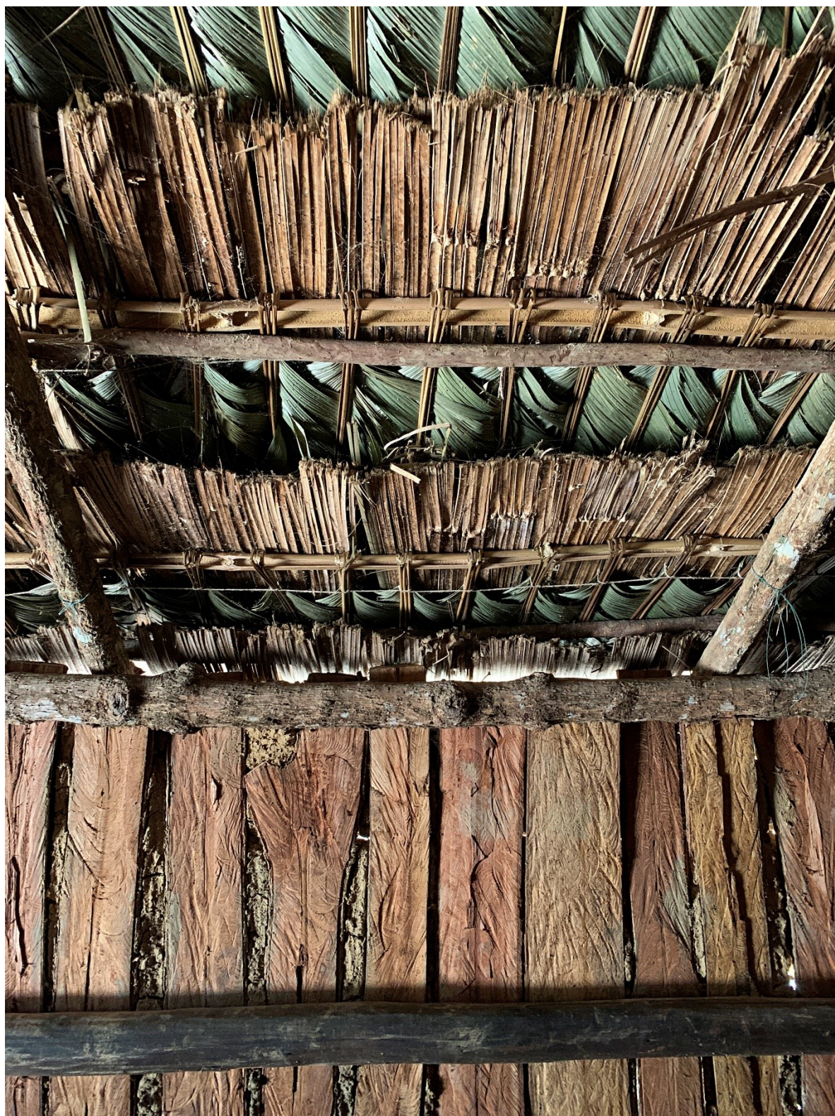
Figura 49 - Detalhes do interior da opy .
