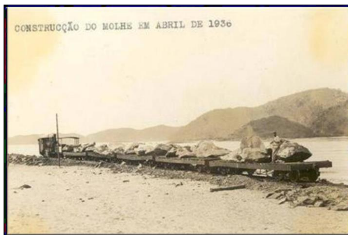
Figura 40: Construção do molhe no porto de Itajaí em 1936.
