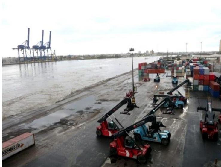
Figura 45: Porto durante a enchente de 2008. Nota-se que o nível da água está na faixa do cais.
