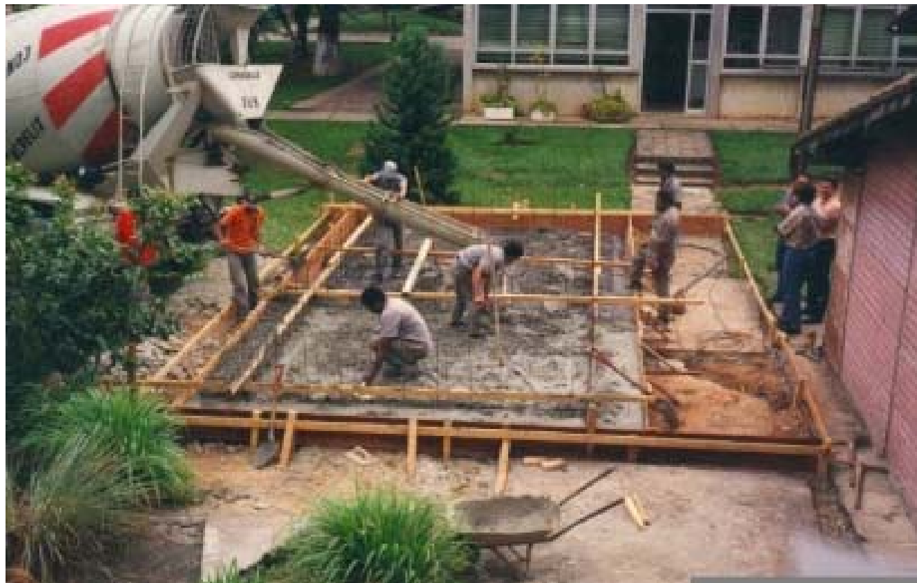
Preparação da fundação
