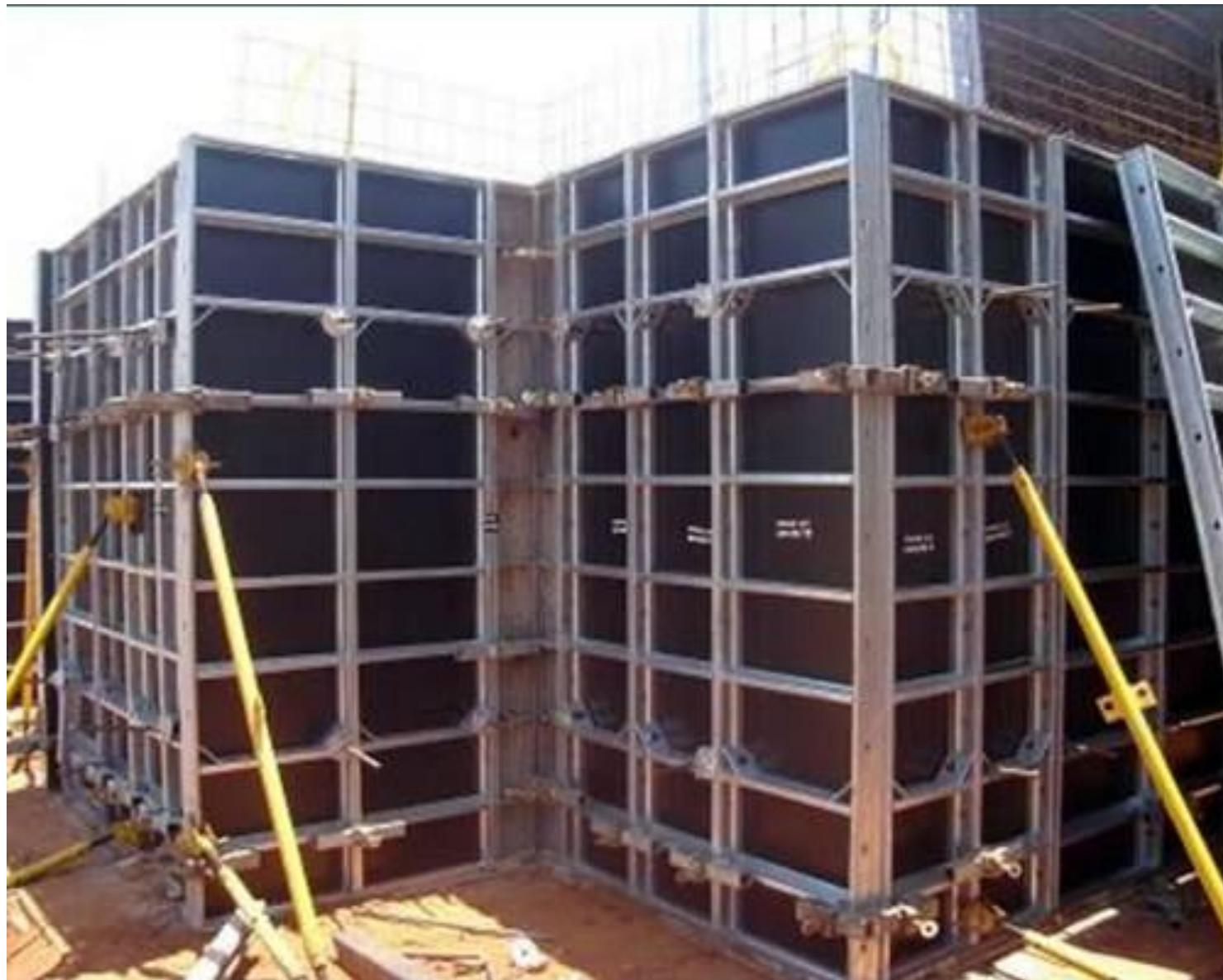
07 Montagem das fôrmas – A montagem obedece à distribuição indicada na planta executiva. Posicione as esquadrias – portas e janelas; coloque as escoras prumadoras que auxiliam na montagem, mantendo os painéis soltos “em pé”; depois execute o ajuste milimétrico do prumo das paredes.
