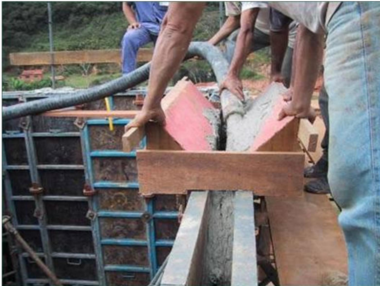
09 Concretagem – Tome precauções para manter a homogeneidade do concreto. Para peças estreitas e altas, o concreto deve ser lançado por janelas abertas na parte lateral, ou por meio de funis ou trombas.
