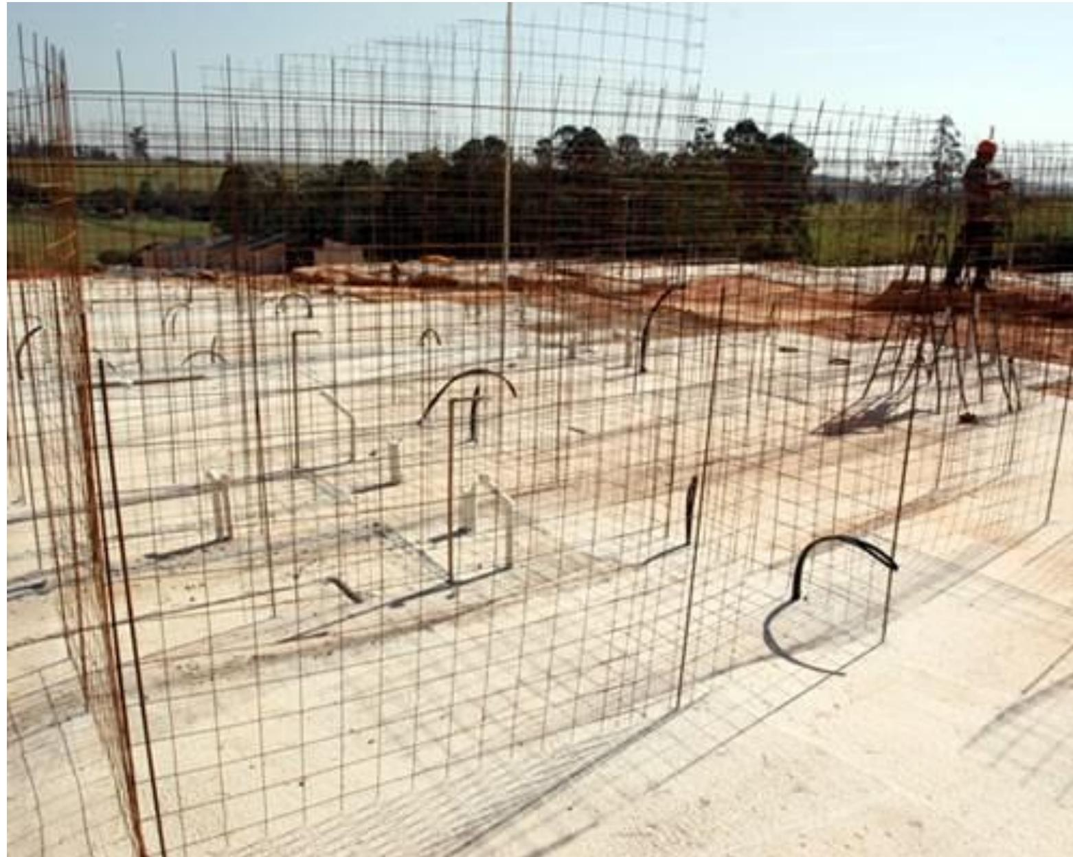
02 Armaduras – A montagem das telas soldadas e reforços deve seguir as especificações do projeto estrutural.
