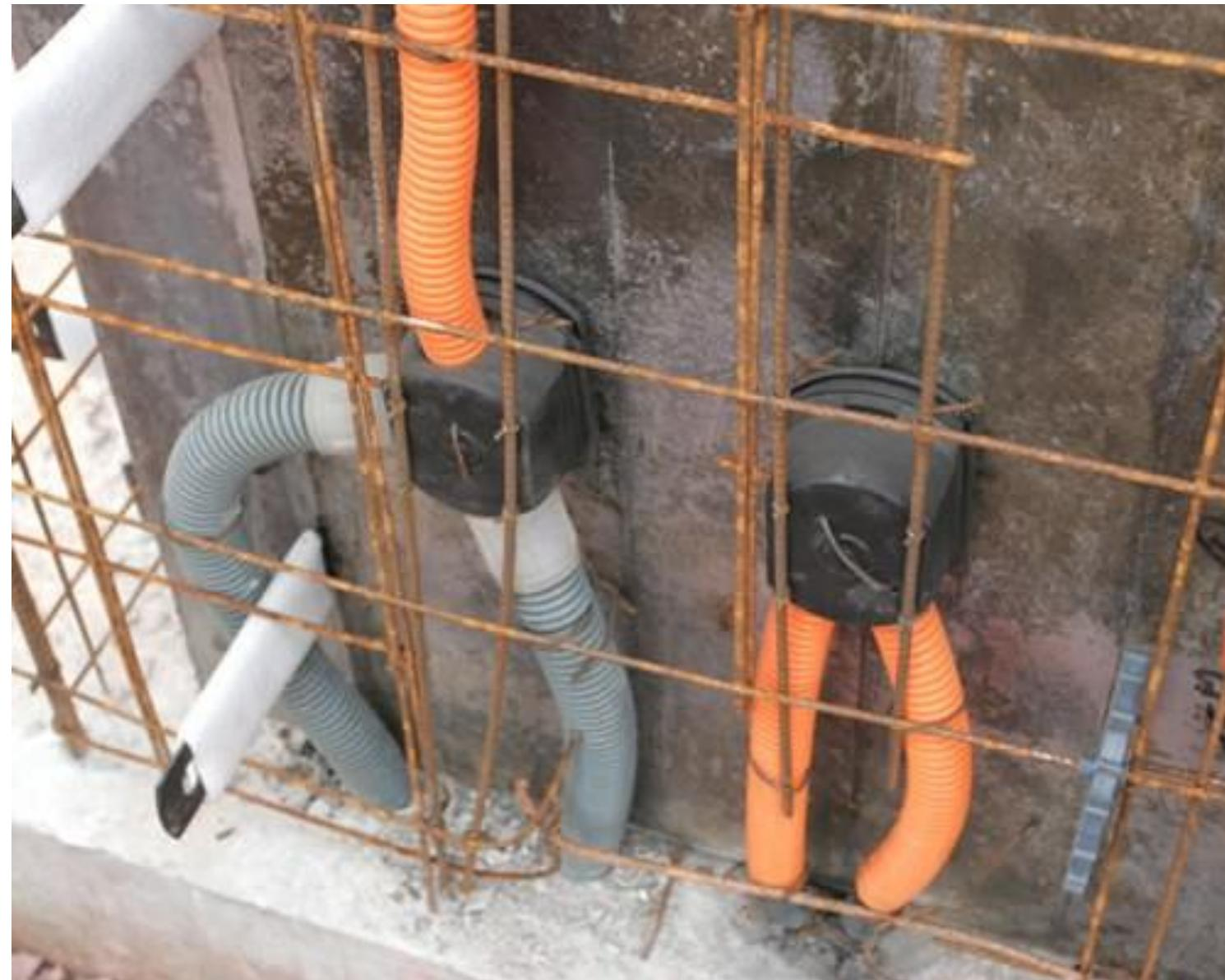
03 Instalações elétricas – São fixadas às armaduras, evitando que se desloquem na concretagem. Use espaçadores entre a rede de dutos e os moldes para garantir seu posicionamento e recobrimento. Preencha as caixas elétricas com papel ou pó de serra para evitar a entrada do concreto.
