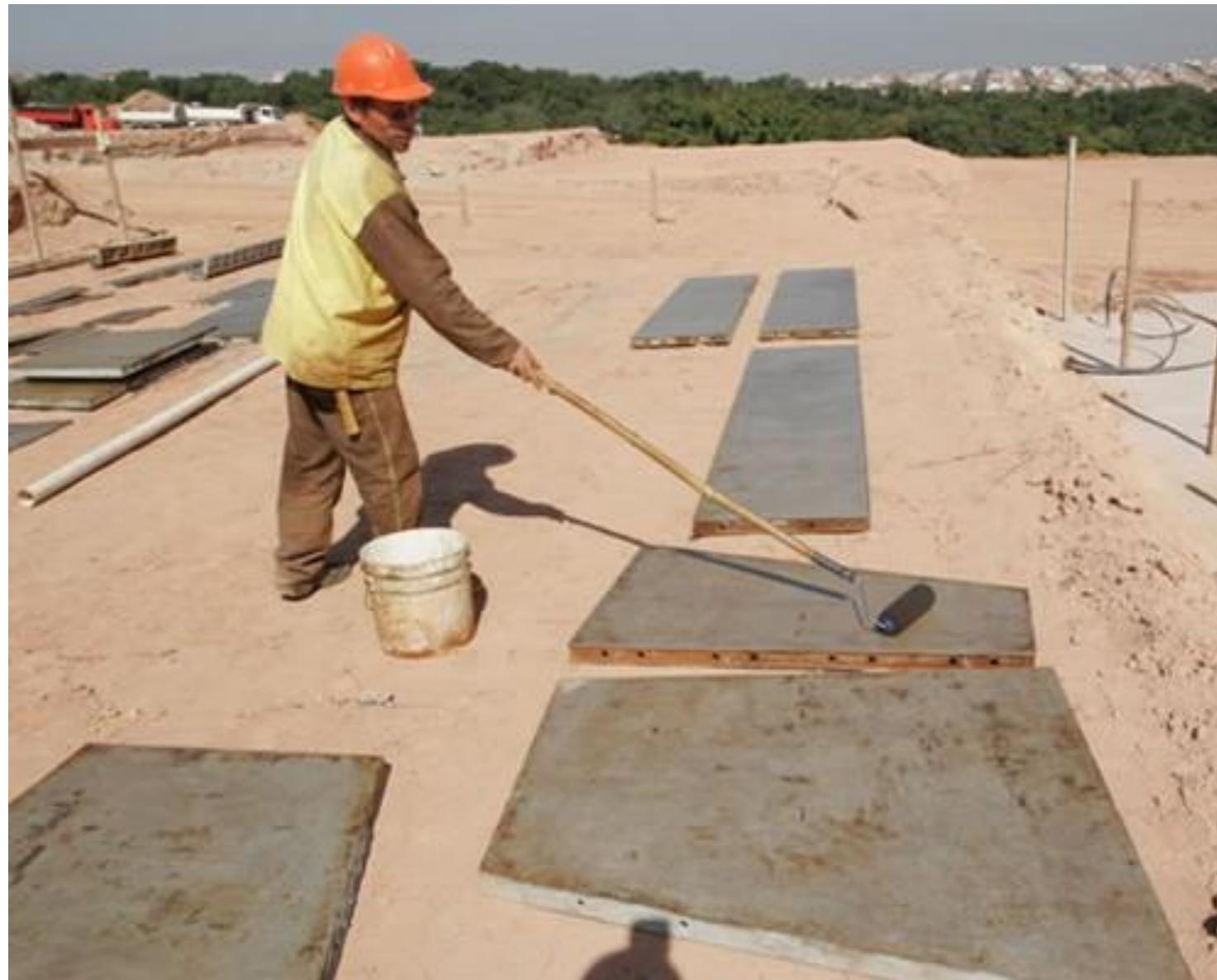
12 Desforma – Após a desmontagem, os painéis devem ser posicionados no chão, ao lado da fundação próxima a ser executada, passando por uma limpeza completa, que consiste na remoção de película de argamassa. Após a limpeza, deve-se aplicar o agente desmoldante.
