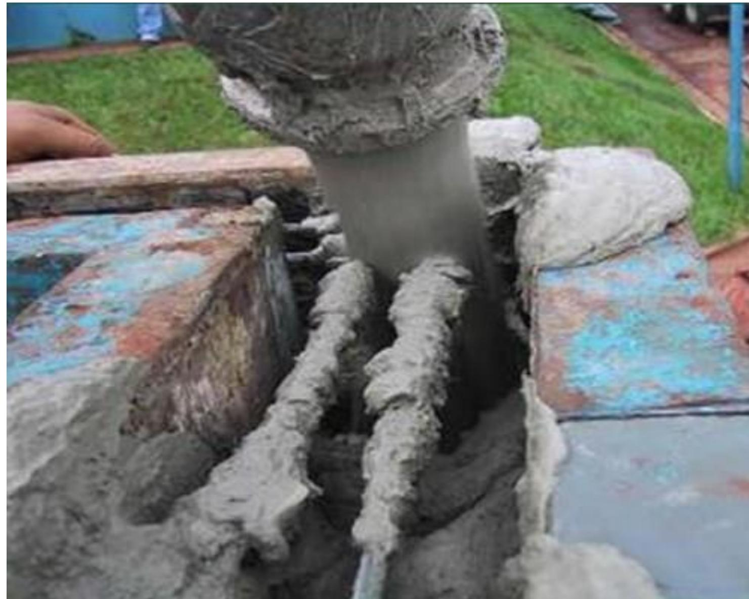
10 Concretagem – O concreto ideal para o sistema é o auto-adensável, que, devido a sua grande fluidez e plasticidade, elimina a necessidade de vibração e a sua viscosidade evita a segregação dos materiais.
