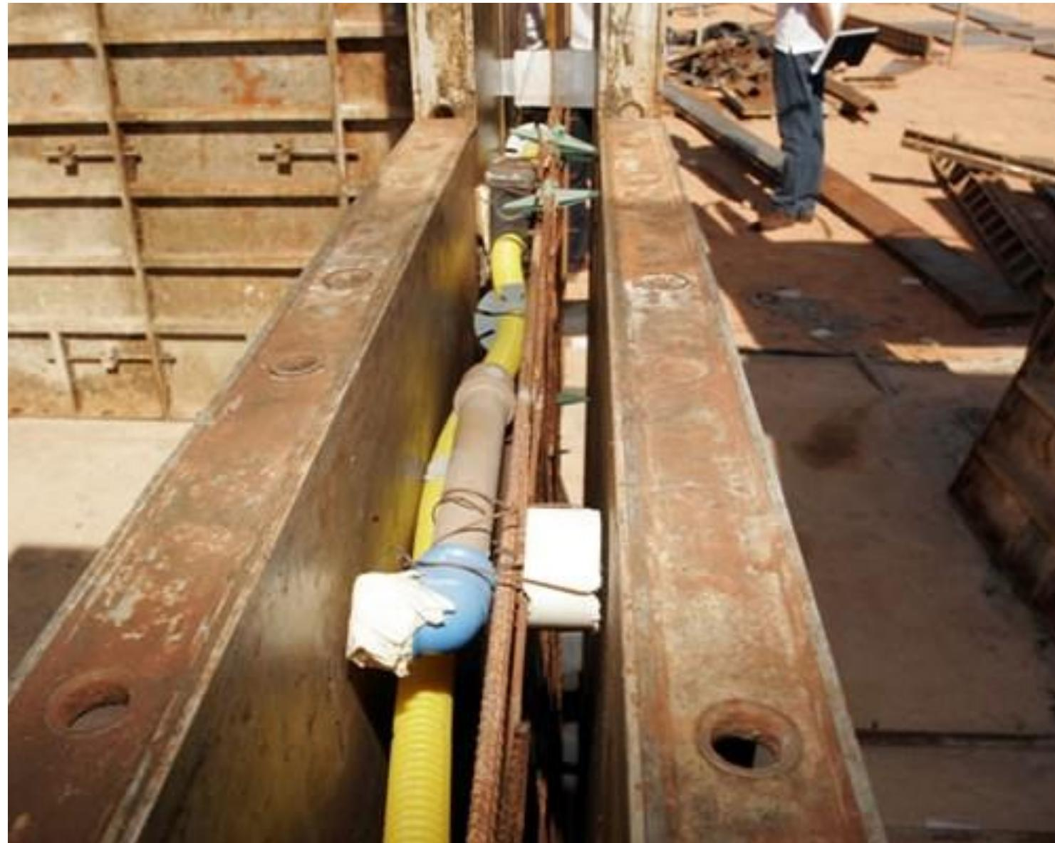
04 Instalações hidráulicas – Além de amarrá-las nas armaduras, devemos colocar espaçadores entre a rede de tubos hidráulicos e as faces dos painéis para garantir o recobrimento e o posicionamento das peças.
