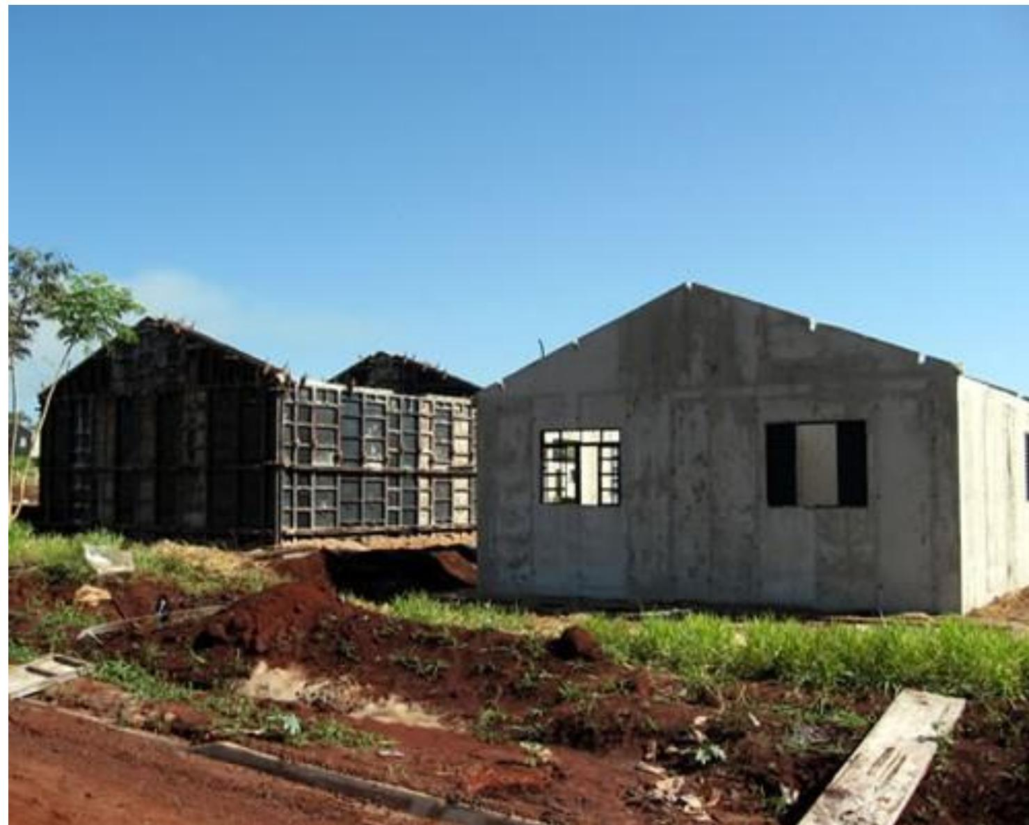
13 Cura – Deve iniciar o mais cedo possível, diminuindo a possibilidade do surgimento de fissuras superficiais, principalmente em lajes. Mantenha a superfície do concreto em contato com água por pelo menos três dias, molhando a parede ao menos 5 vezes ao dia.
