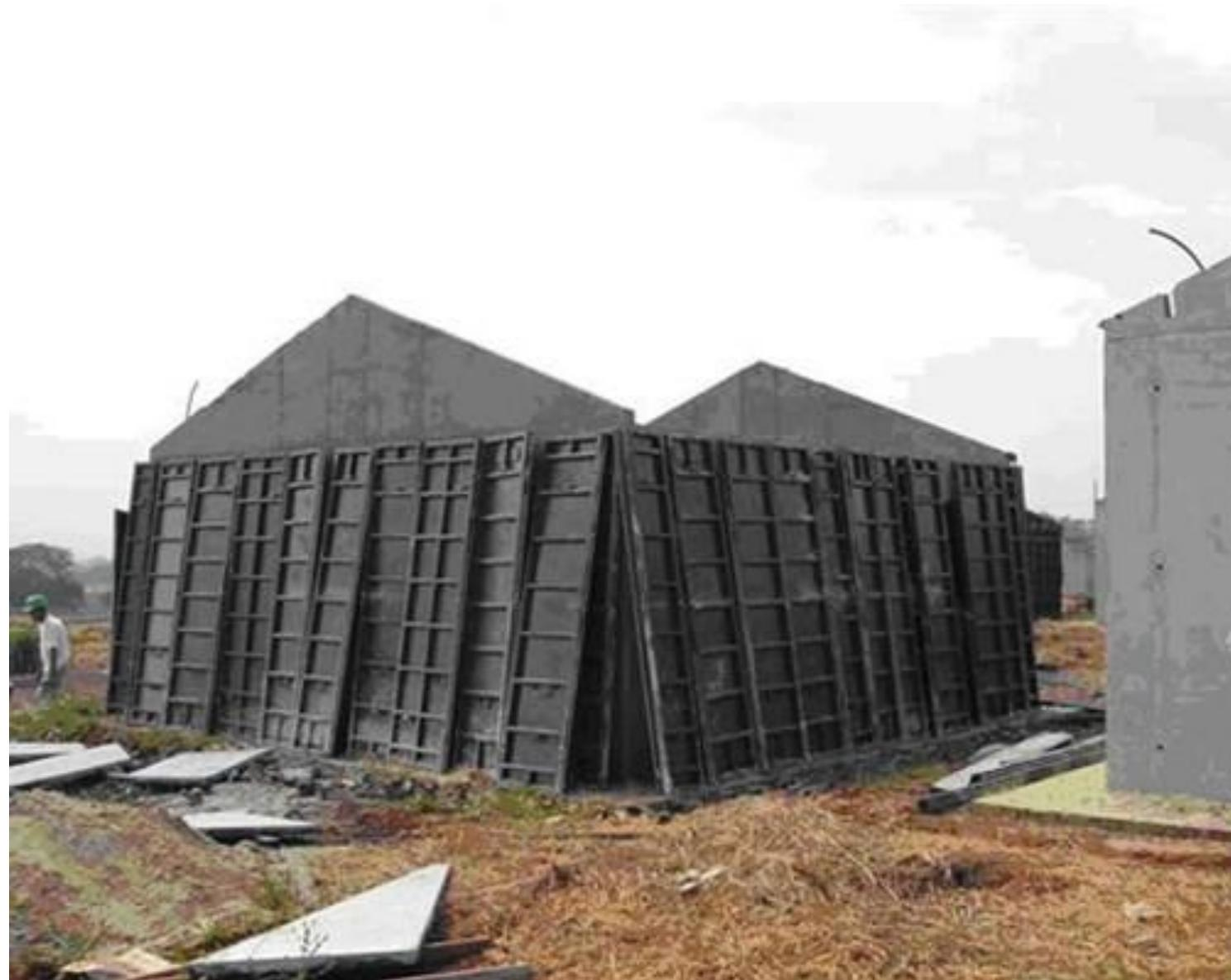
11 Desforma – Deve ser feita quando o concreto atingir a resistência e a elasticidade prevista no projeto. A retirada das fôrmas e do escoramento deve ser feita sem choques, para evitar o aparecimento de fissuras por ações mecânicas.
