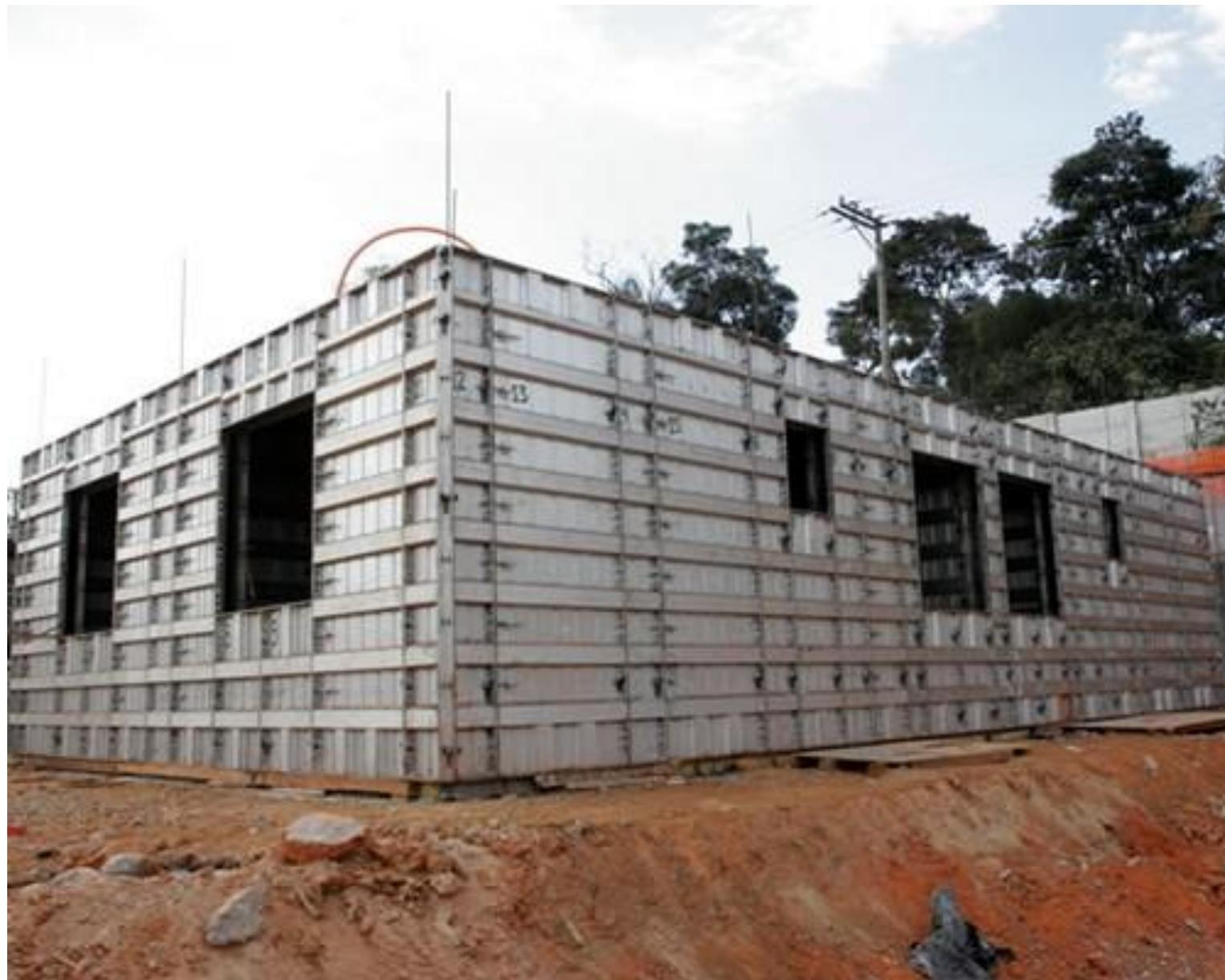
06 Montagem das fôrmas – Os painéis devem ser montados em sequência, por meio de conectores como grampos ou pinos.
