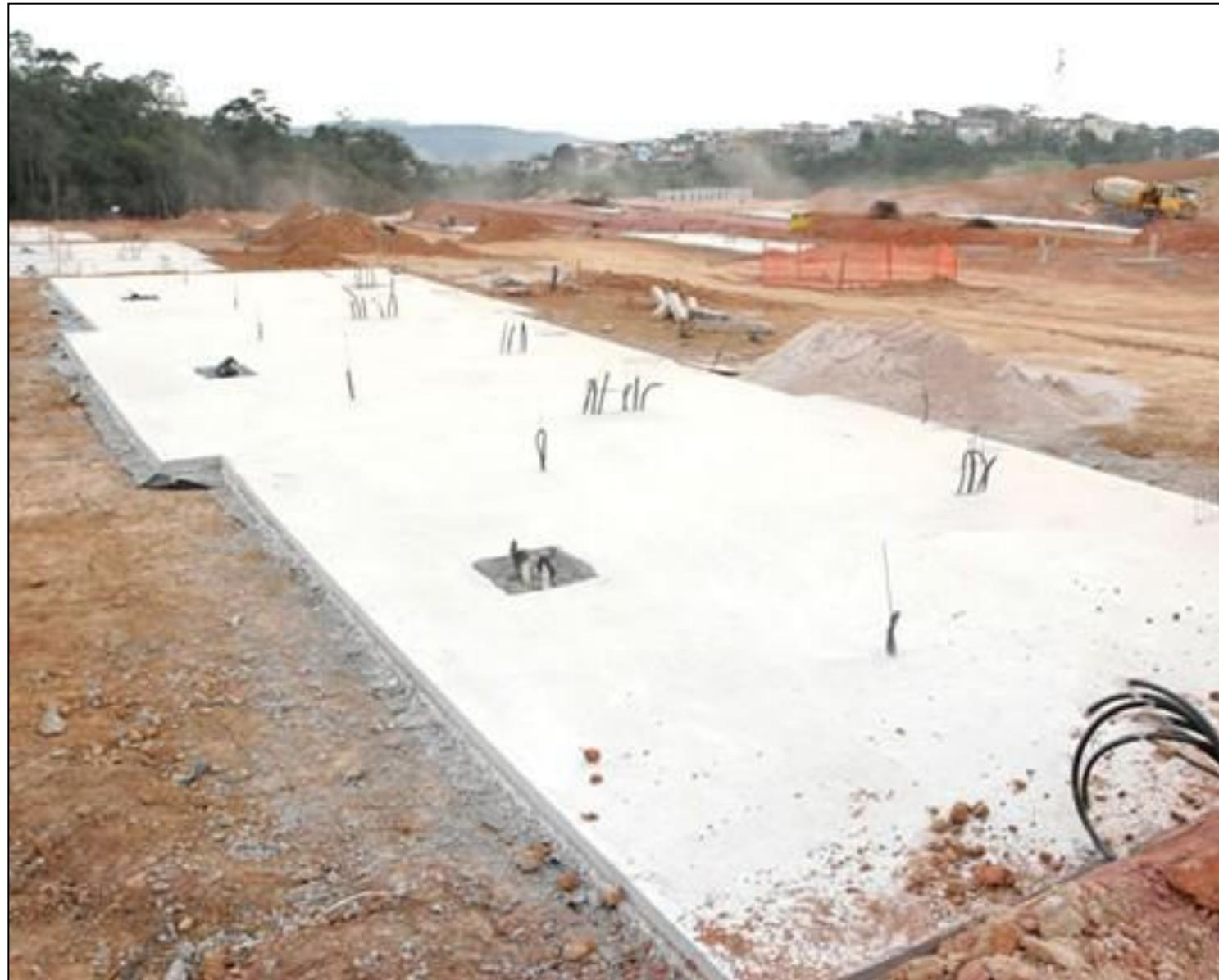
01 Fundações – Independente da tipologia, as fundações devem ser executados com nivelamento rigoroso, permitindo a correta montagem do sistema de moldes.
