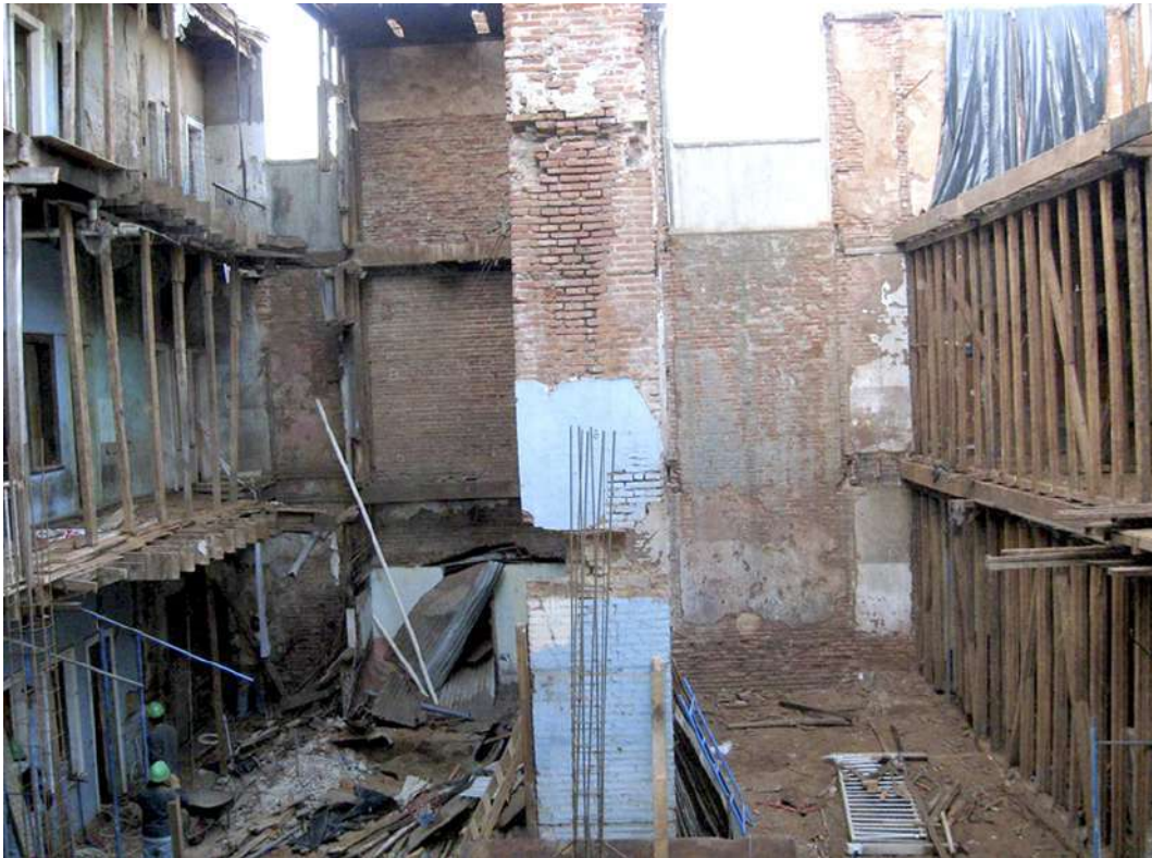
Figura 06 – Durante a recuperação dos apartamentos do edifício.
