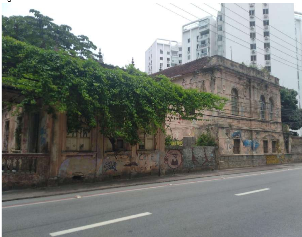
Figura 38 – Fachada do casarão eclético e anexo localizado na Rua Frei Caneca.
