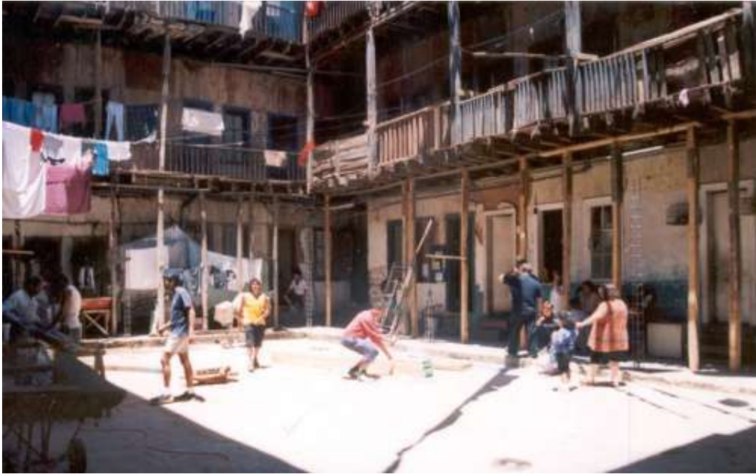
Figura 05 – Antes da recuperação dos apartamentos do edifício.
