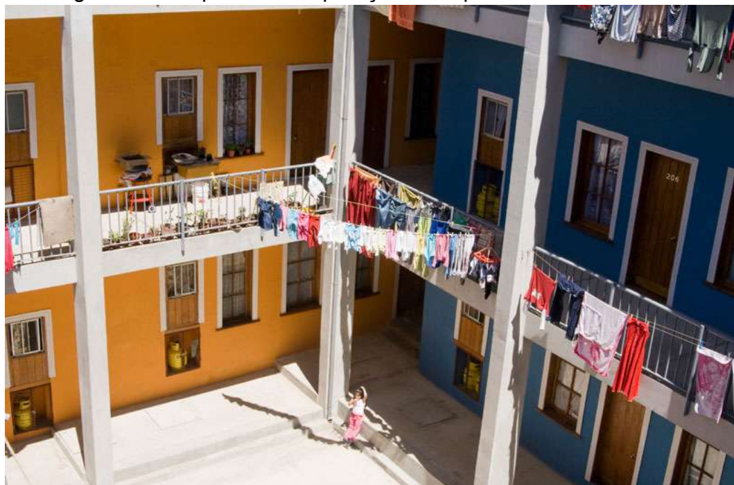
Figura 07 – Depois da recuperação dos apartamentos do edifício.
