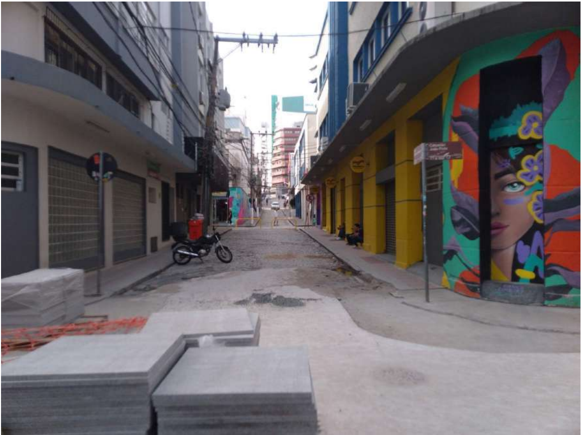
Figura 33 – Obras da Revitalização do Centro Leste.
