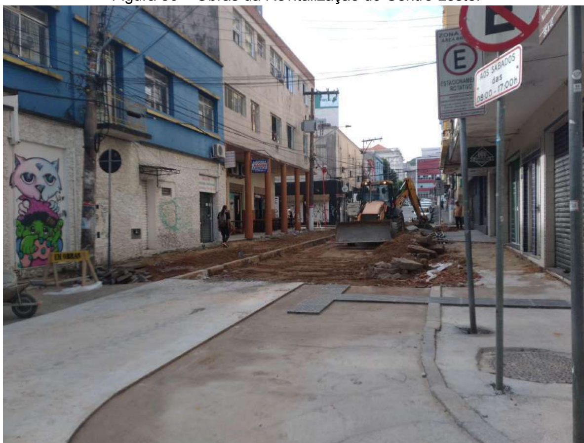
Figura 36 – Obras da Revitalização do Centro Leste.
