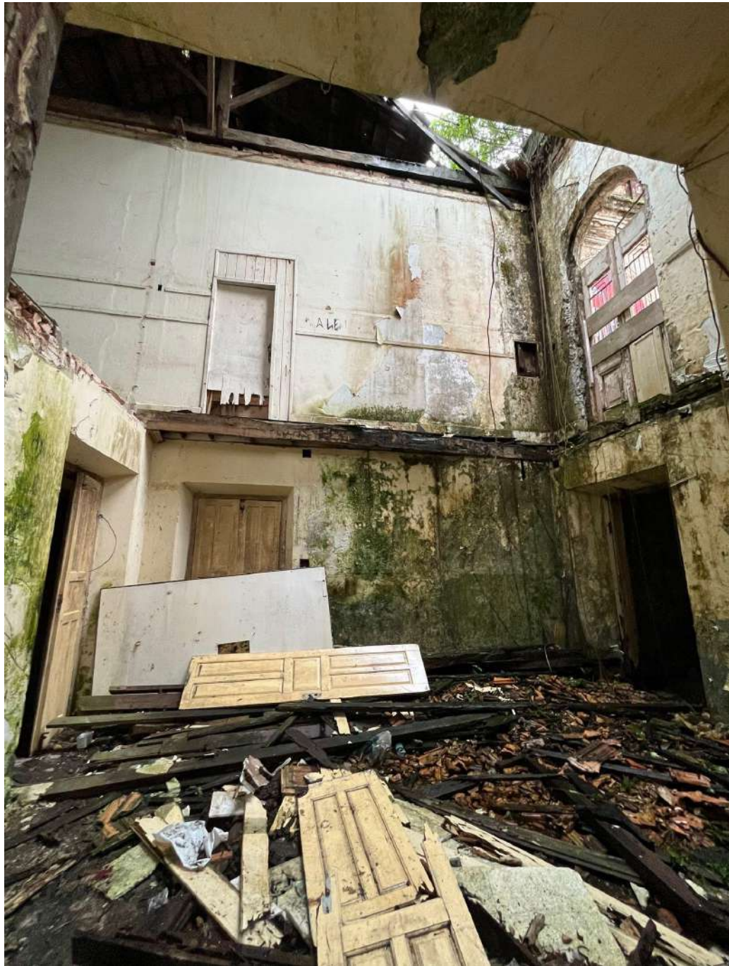
Figura 40 – Interior do casarão eclético localizado na Rua Frei Caneca.
