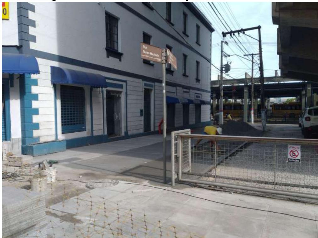
Figura 37 – Obras da Revitalização do Centro Leste.
