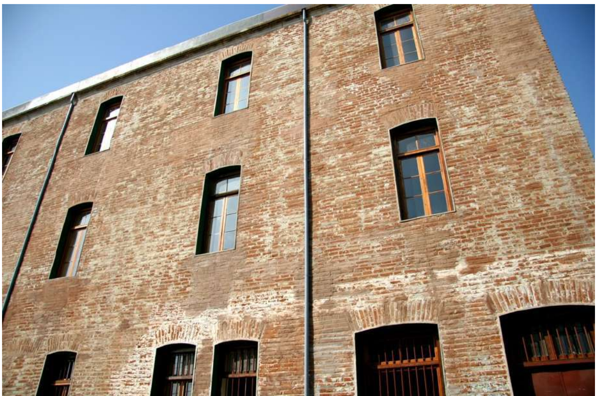
Figura 04 – Fachada do edifício Población Obrera de la Unión.
