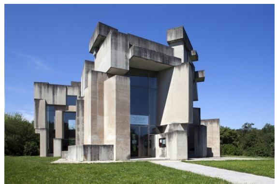
Figura 34 – Igreja de Wotrubas, em Viena (1976), na Áustria.
