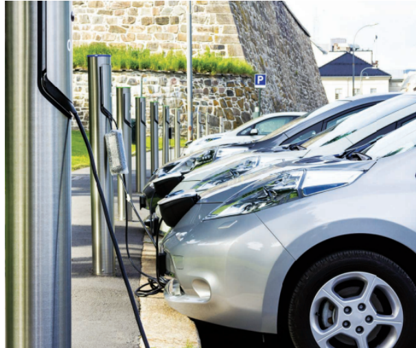
Figura 3 – Foto de carregadores de veículos elétricos civis
