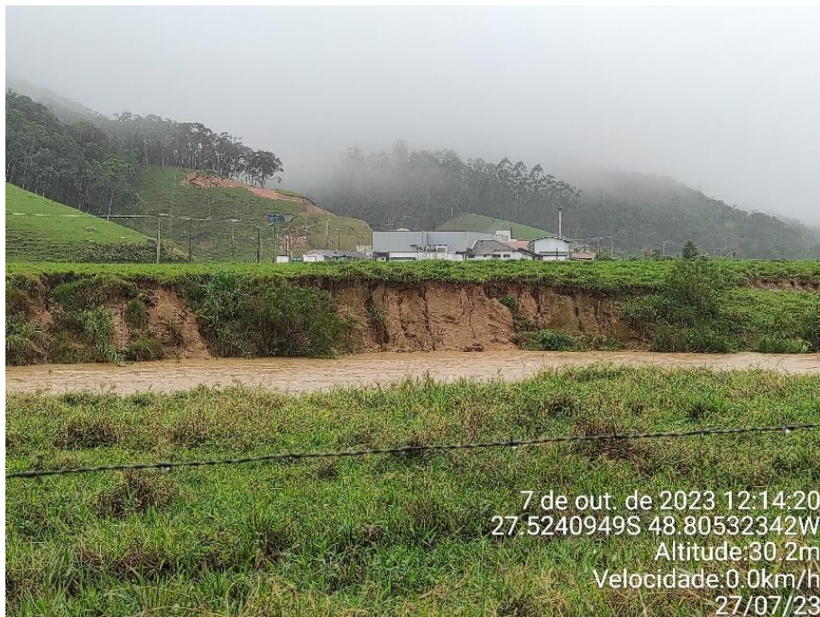
Figura 38 – Erosão das margens do rio o trecho em estudo, na estaca 60+0
