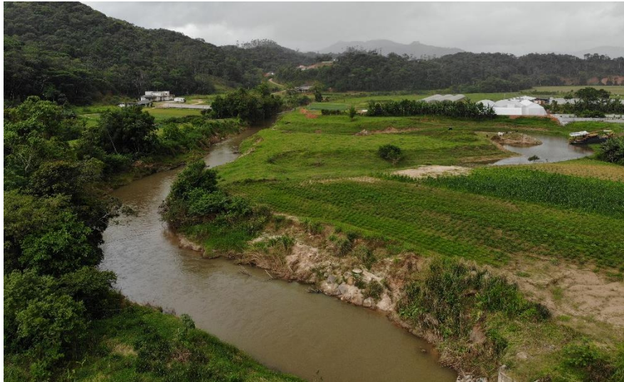
Figura 39 – Erosão das margens do rio o trecho em estudo, na estaca 140+0
