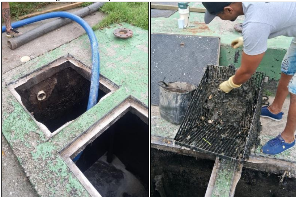
Figura 32 – Limpeza da caixa e cestos na EEE Atobás.
