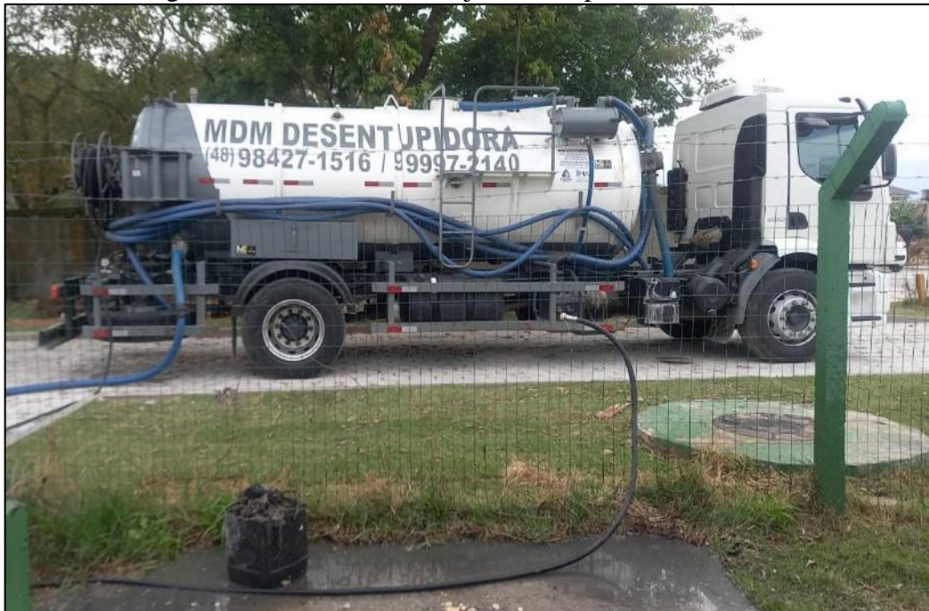
Figura 29 – Caminhão hidrojato de empresa terceirizada.
