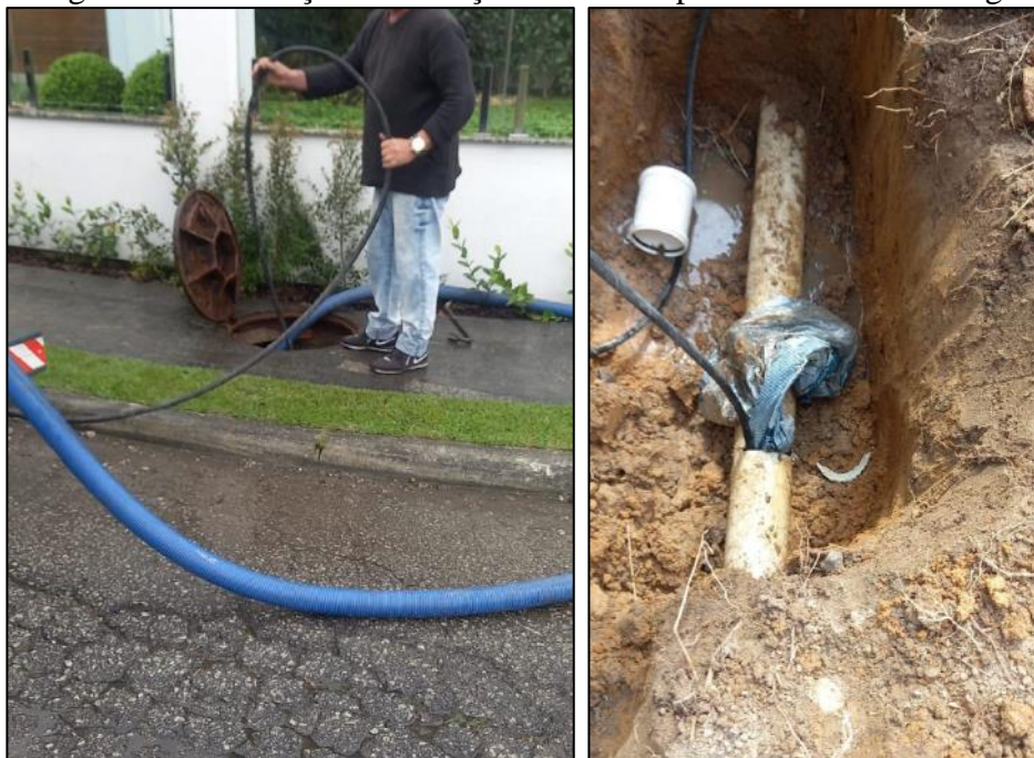
Figura 30 – Execução de serviços de desentupimento de rede de esgoto.
