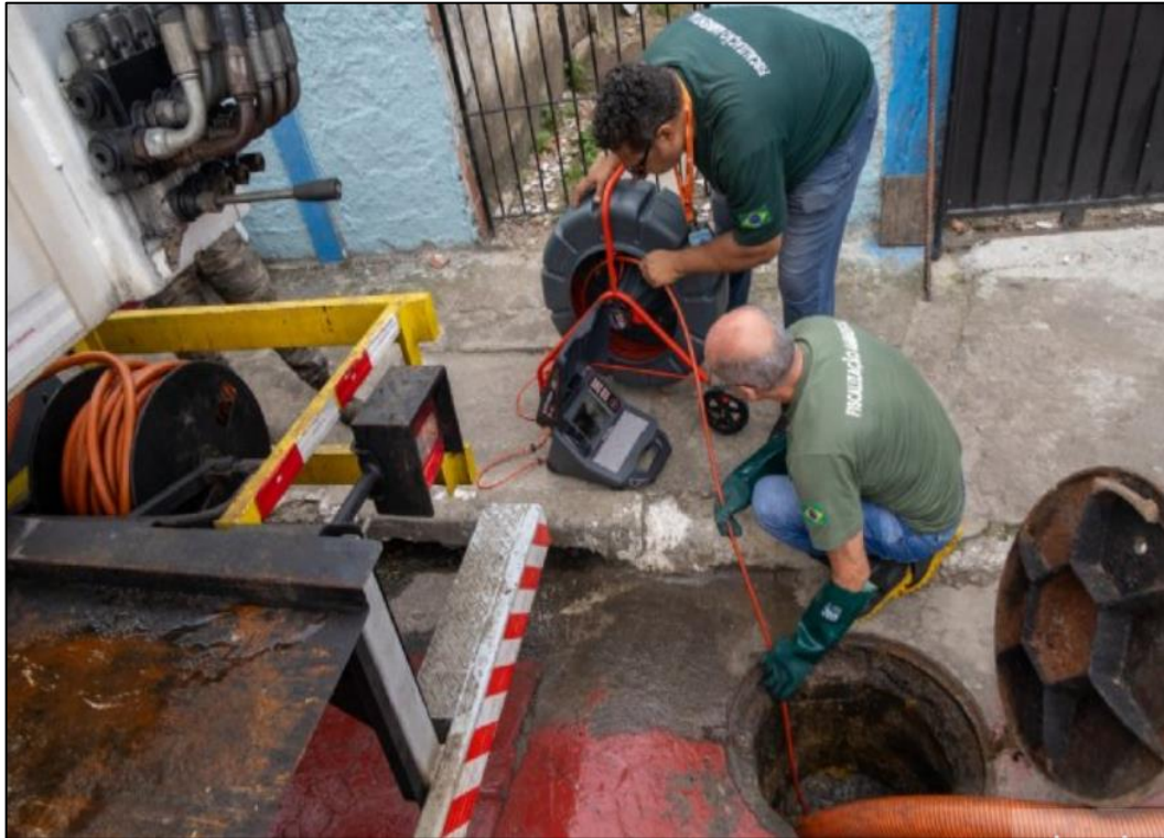
Figura 2 – Inspeção por vídeo da rede coletora de esgoto.
