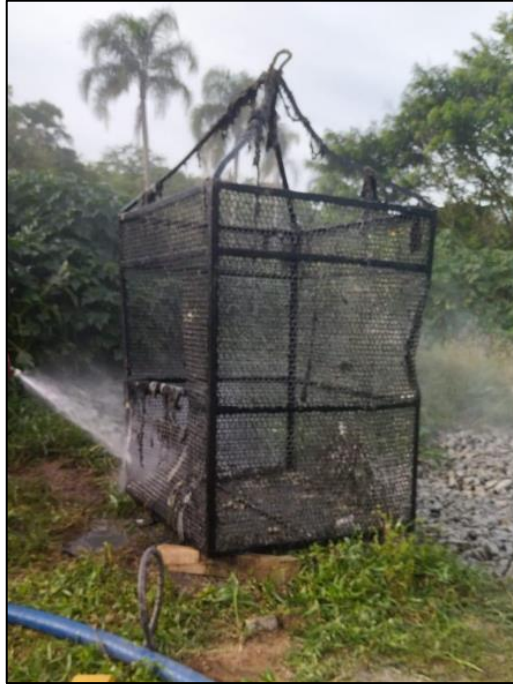
Figura 33 – Limpeza de cesto da EEE Atobás.
