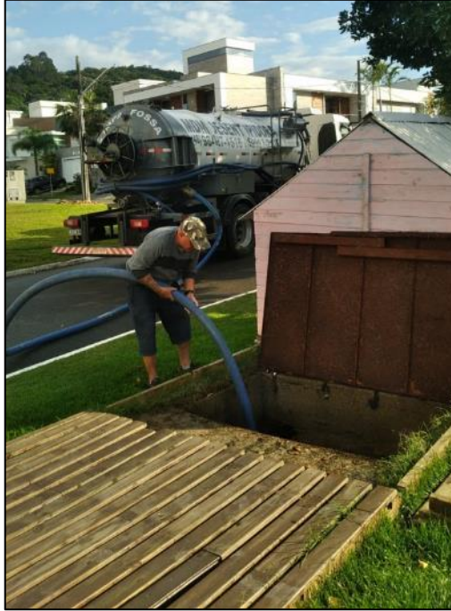
Figura 31 – Limpeza EEE Parque da Pedra com caminhão hidrojato.
