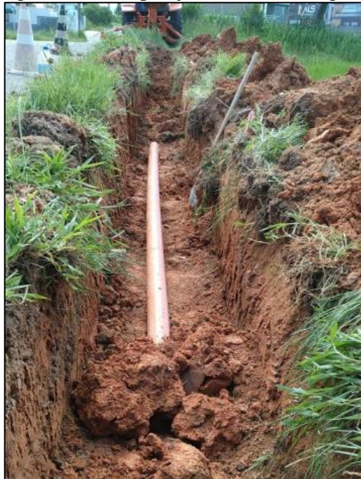
Figura 34 – Ampliação de rede de esgoto.
