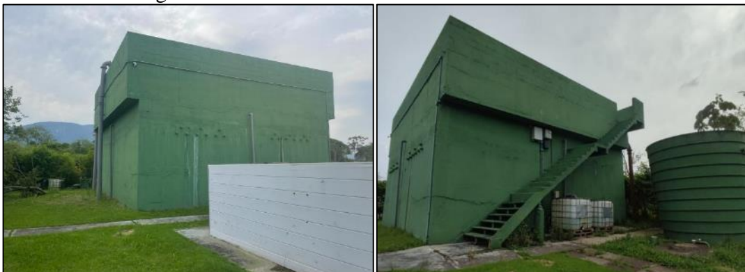
Figura 24 – Reator UASB – ETE SAE Pedra Branca.
