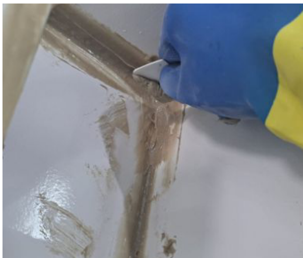
Figura 24 – Aplicação da massa união com fibra moída da EGC Fiberglass.
