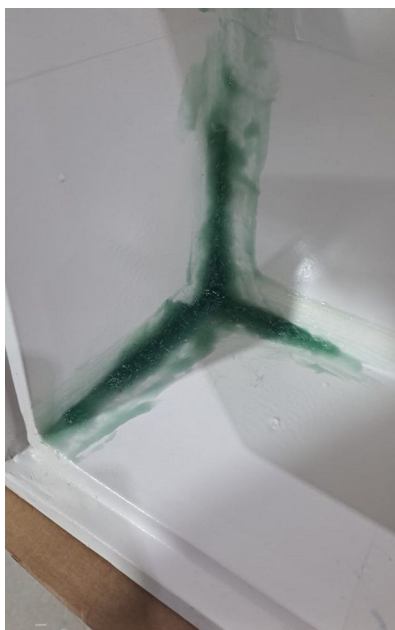
Figura 26 – Aplicação da Massa B.
