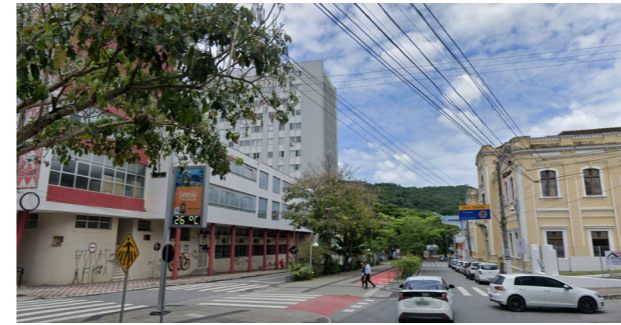
Figura XXVI. Vista 01 - Avenida Hercílio Luz.
