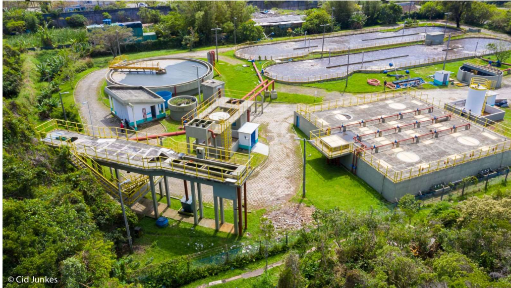
Figura 5 - Estação de Tratamento de Efluentes da Lagoa da Conceição
