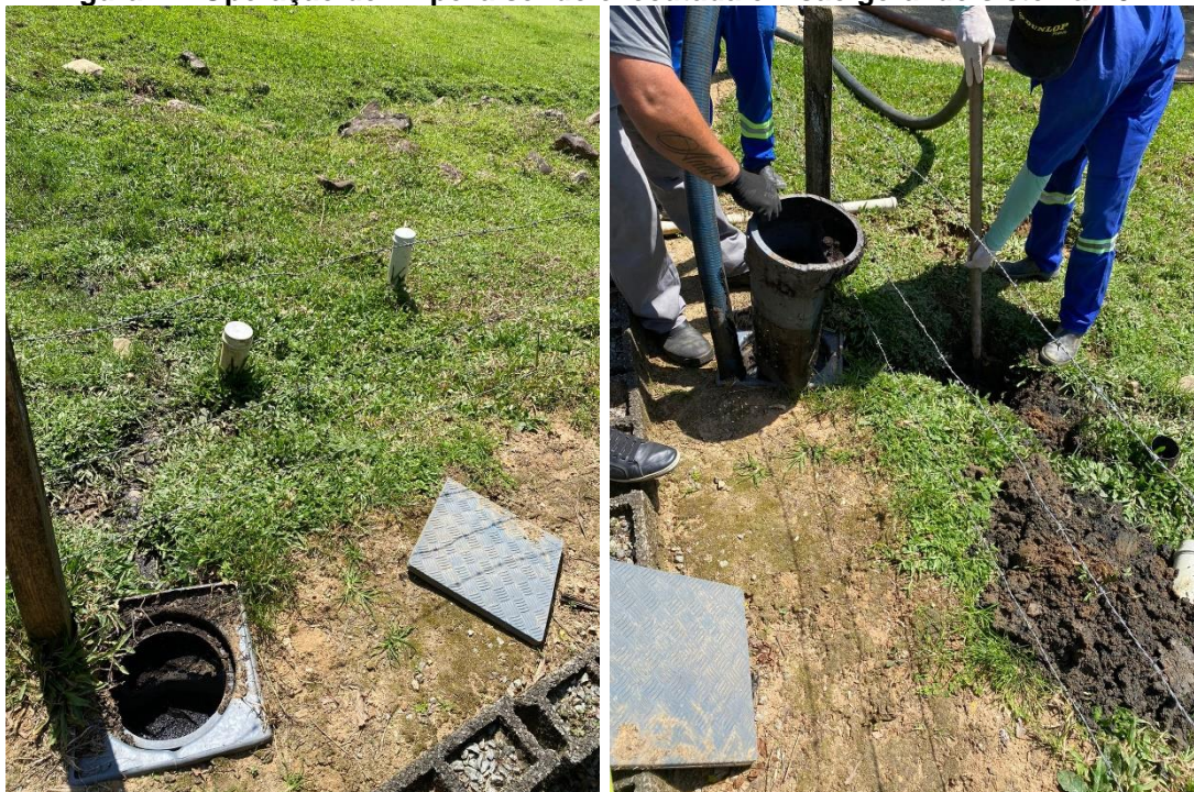
Figura 14: Operação de limpeza sendo executada e visão geral do sistema - 04
