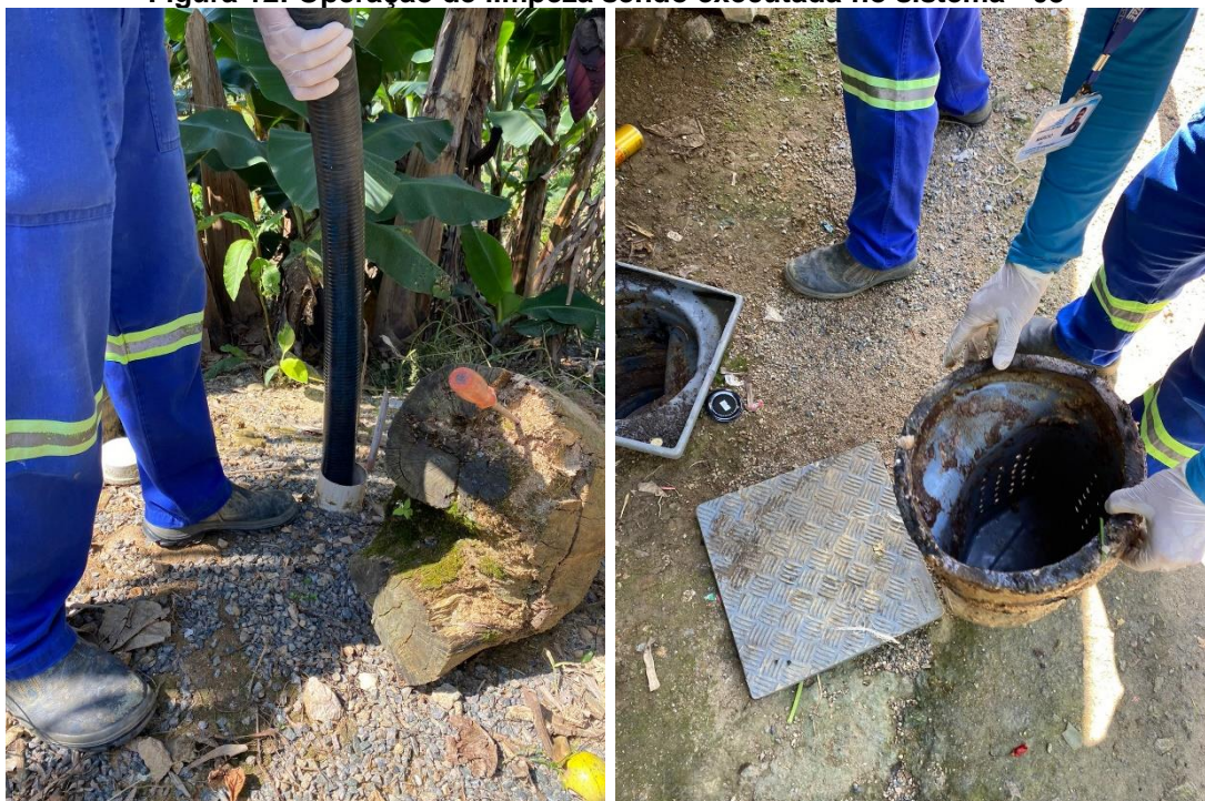
Figura 12: Operação de limpeza sendo executada no sistema - 03
