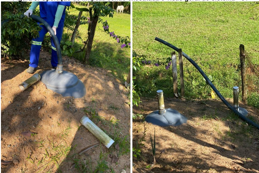
Figura 8: Operação de limpeza sendo executada e visão geral do sistema - 01
