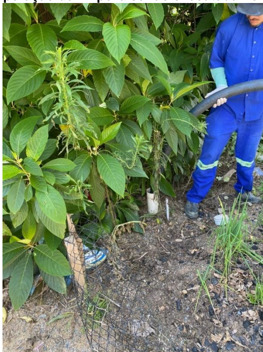
Figura 10: Operação de limpeza sendo executada no sistema - 02
