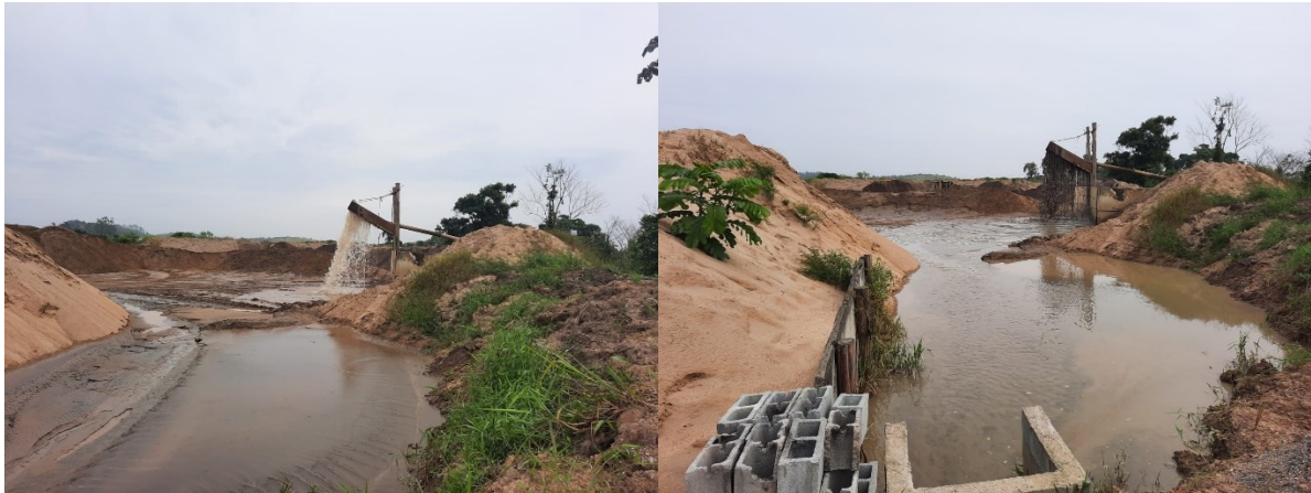
Figura 3 - Bacia de decantação. A esquerda tubulação de recalque conectado à grelha na saída, despejando na bacia de decantação. A direita, escoamento da água para caixa de drenagem. Fonte: a autora.
