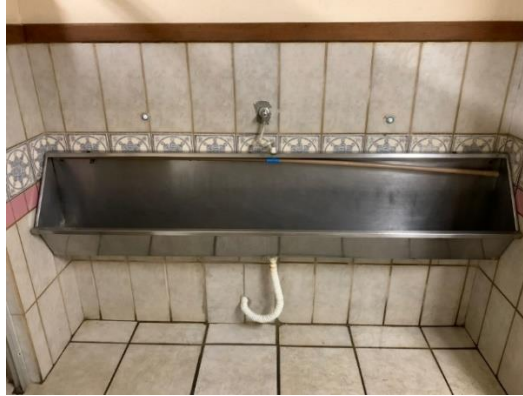
Figura 11 – Mictório tipo cascata no banheiro do pavimento térreo.
