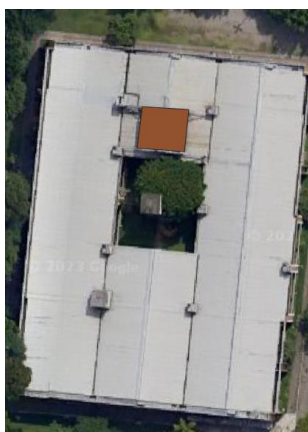
Figura 25 – Polígono 3: área de superfície sobre a área técnica localizada sobre o telhado.
