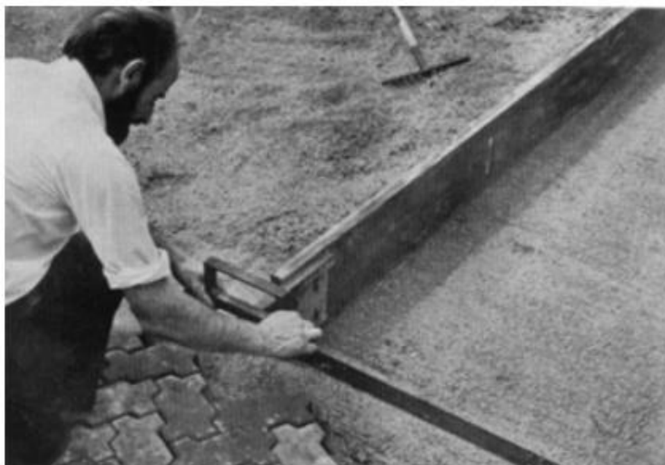
Figura 12 – Camada de Assentamento.
