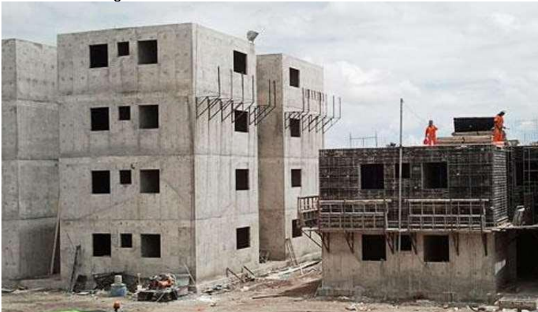
Figura 2 - Paredes de concreto moldadas in loco
