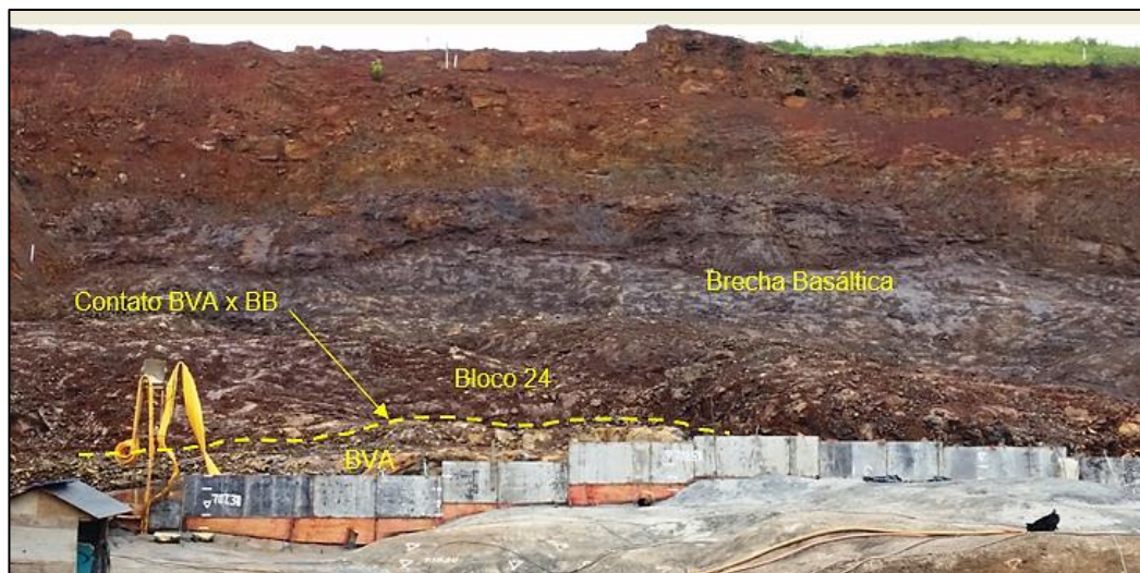
Figura 4-5. Contato entre brecha basáltica e basalto vesicular amigdaloidal exposto após as escavações.
