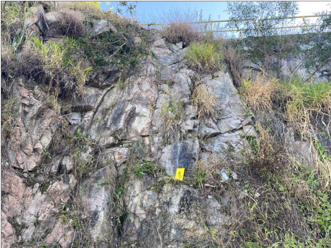
Figura 43. Detalhes da zona geomecânica 2, evidenciando um maciço com baixo grau de faturamento.
