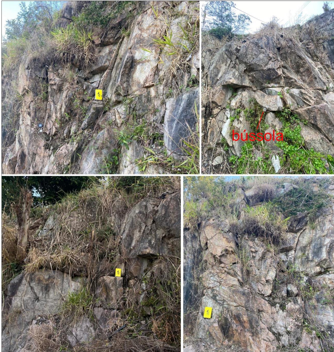
Figura 44. Detalhes da zona geomecânica 3, evidenciando um maciço com médio grau de faturamento e fraturas mais abertas.
