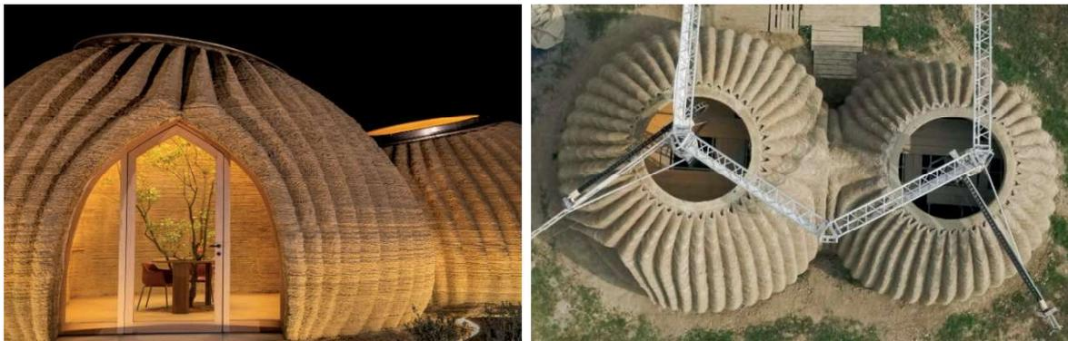
Figura 1: Casas inspiradas em abelhas impressas com mega impressora à base de terra. Adaptado de Mega Game (2023).
