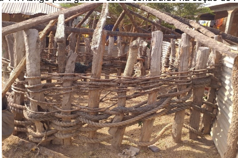
Figura 14: Abrigo para gados "coral" construído na seção de Nhacra.
