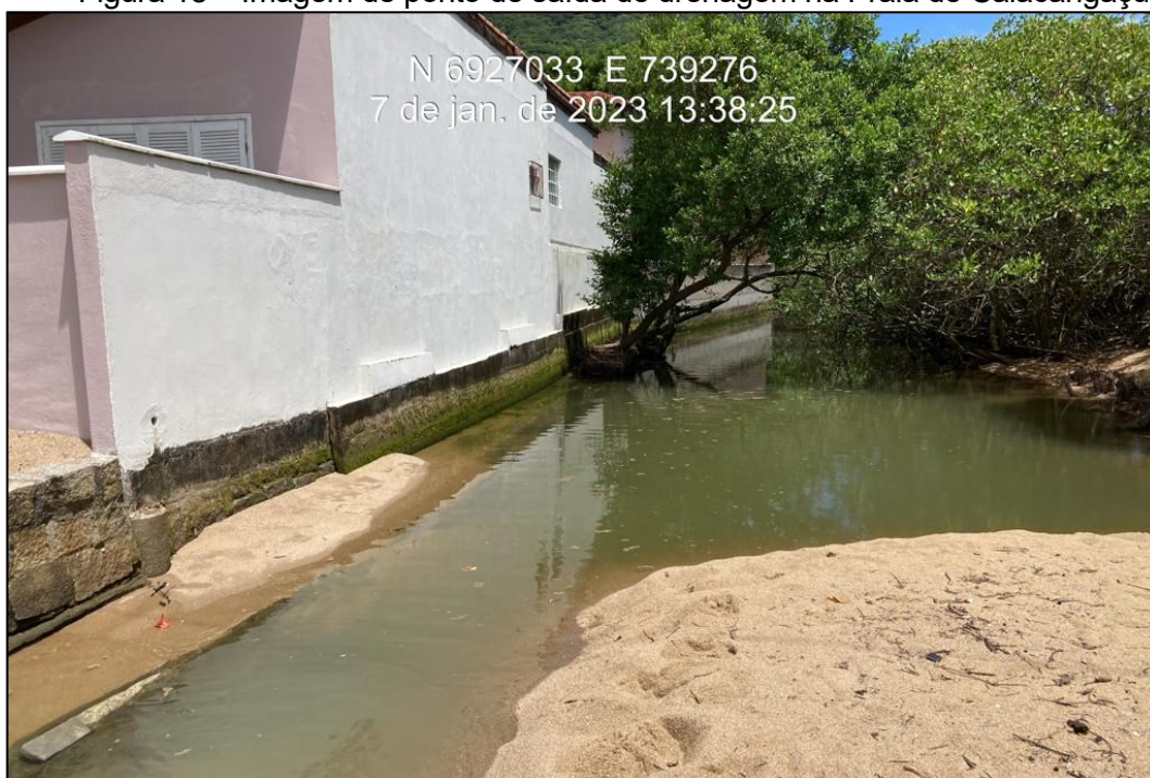
Figura 18 – Imagem de ponto de saída de drenagem na Praia de Caiacangaçu
