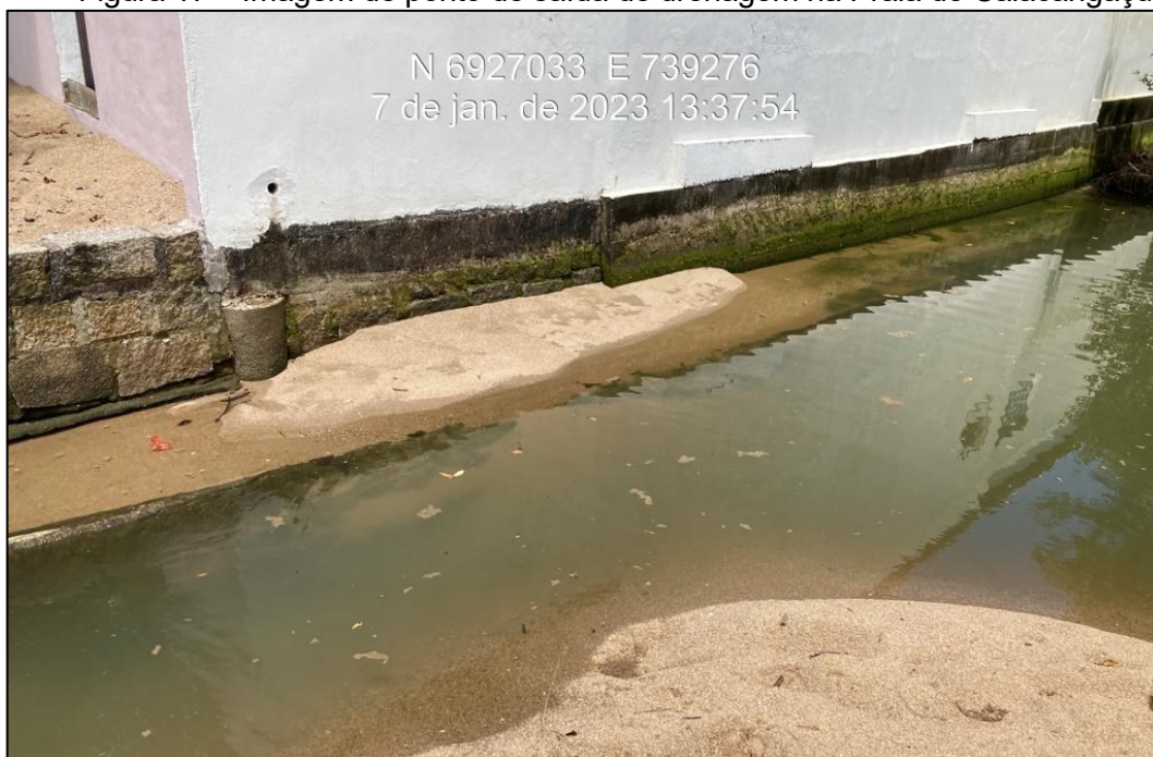
Figura 17 – Imagem de ponto de saída de drenagem na Praia de Caiacangaçu
