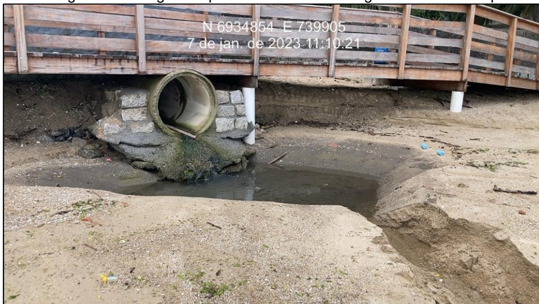
Figura 14 – Imagem de ponto de saída de drenagem na Praia da Tapera
