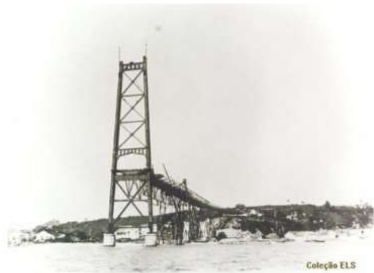
Fig. 64: Imagem da construção da torre lado continental
