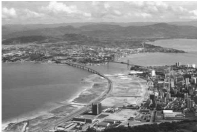
Fig. 38 - Obras do aterro da Baía Sul
