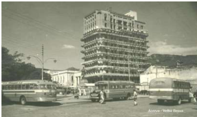
Fig. 12 - Construção do Banco Nacional do Comércio
