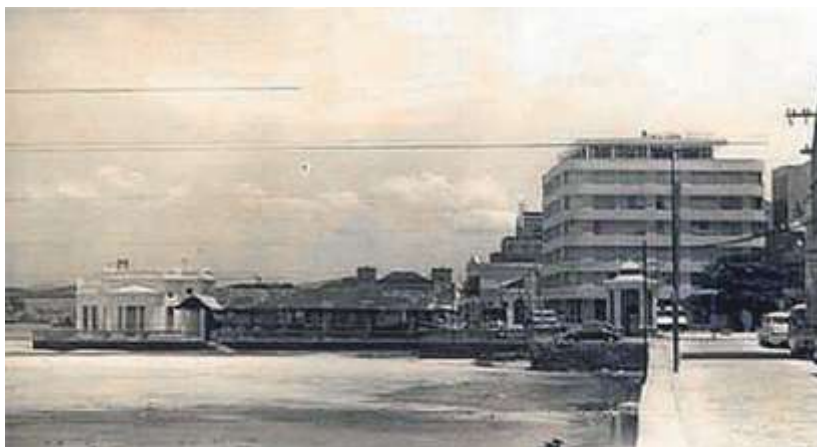
Fig. 9 - Edificação do antigo Hotel La Porta com fachada alterada e acréscimo de dois pavimentos
