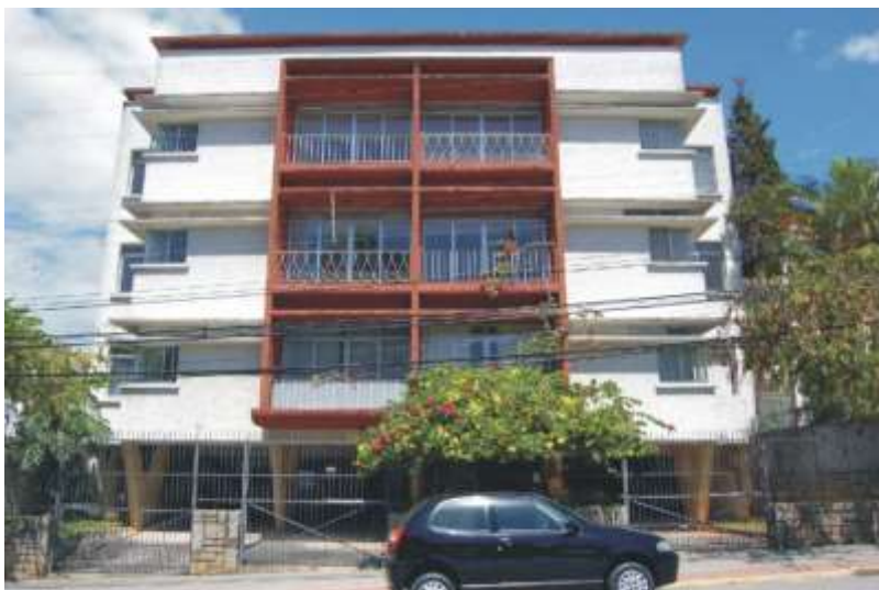
Fig. 44 - Fachada da edificação
