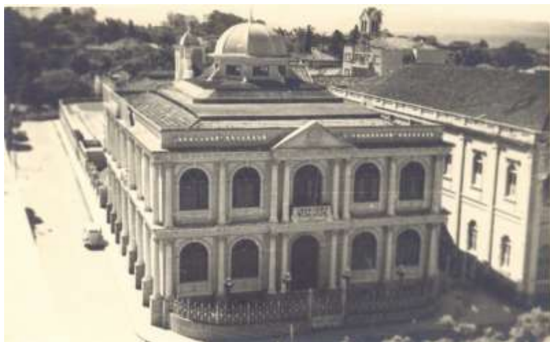
Fig. 32 – Edificação da Assembleia Legislativa – 1950
