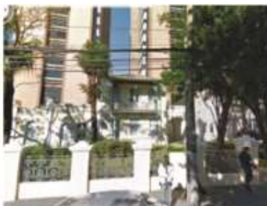
Fig. 117 - Vista da rua Bocaiúva
