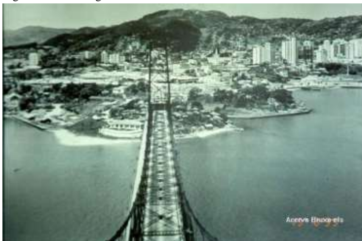
Fig. 61 - Vista longitudinal da Ponte Hercílio Luz
