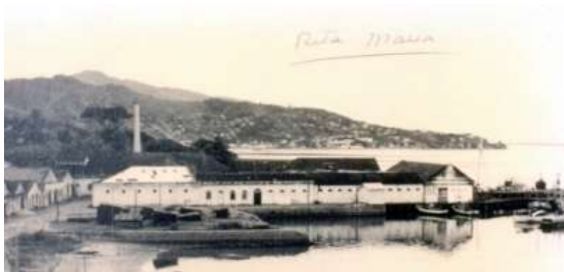
Fig.58 - Armazéns da Fábricas de Pregos e Pontas
