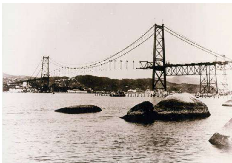
Fig. 65: Imagem da construção do vão central
