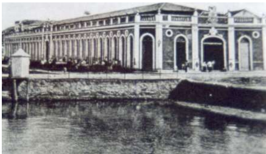
Fig. 30 - Nova construção do Mercado Público
