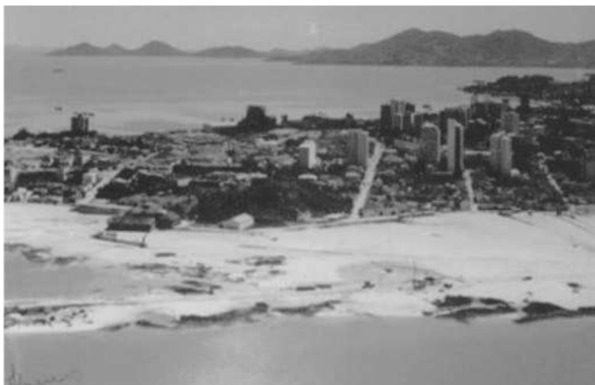
Fig. 37 - Início das obras do aterro
