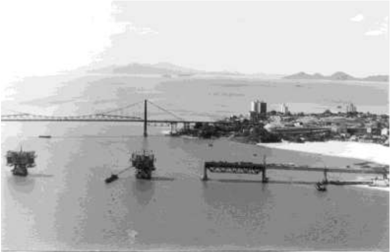
Fig. 67: Imagem da construção da Ponte Colombo Salles
