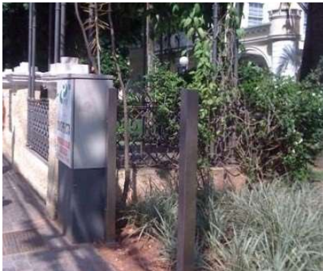
Fig. 78 - O vidro - Muro permissivo
