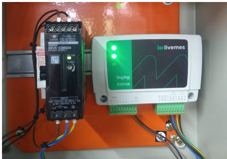
Figura 4 - Coletor IoT LiveMES operando em uma máquina
