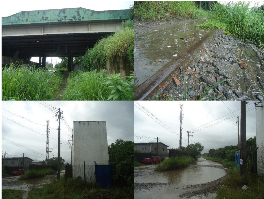
Figura 36 – O viaduto e os trilhos residuais. A cabine de sinalização e o início da estrada de terra ao longo dos antigos trilhos da antiga ferrovia EFS
