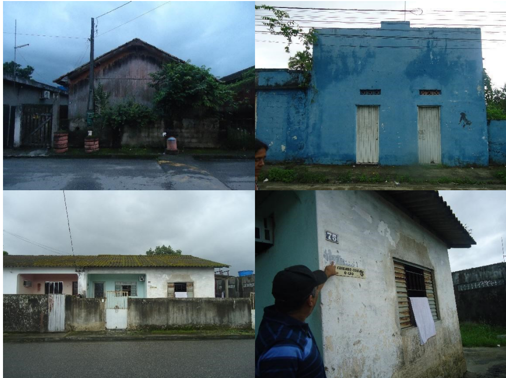
Figura 38 – Um chalé de madeira e uma outra edificação em azul, supostamente do período inicial da ocupação de Samaritá no século XX. A casa do chefe da estação nº 75 e seu morador contemporâneo
