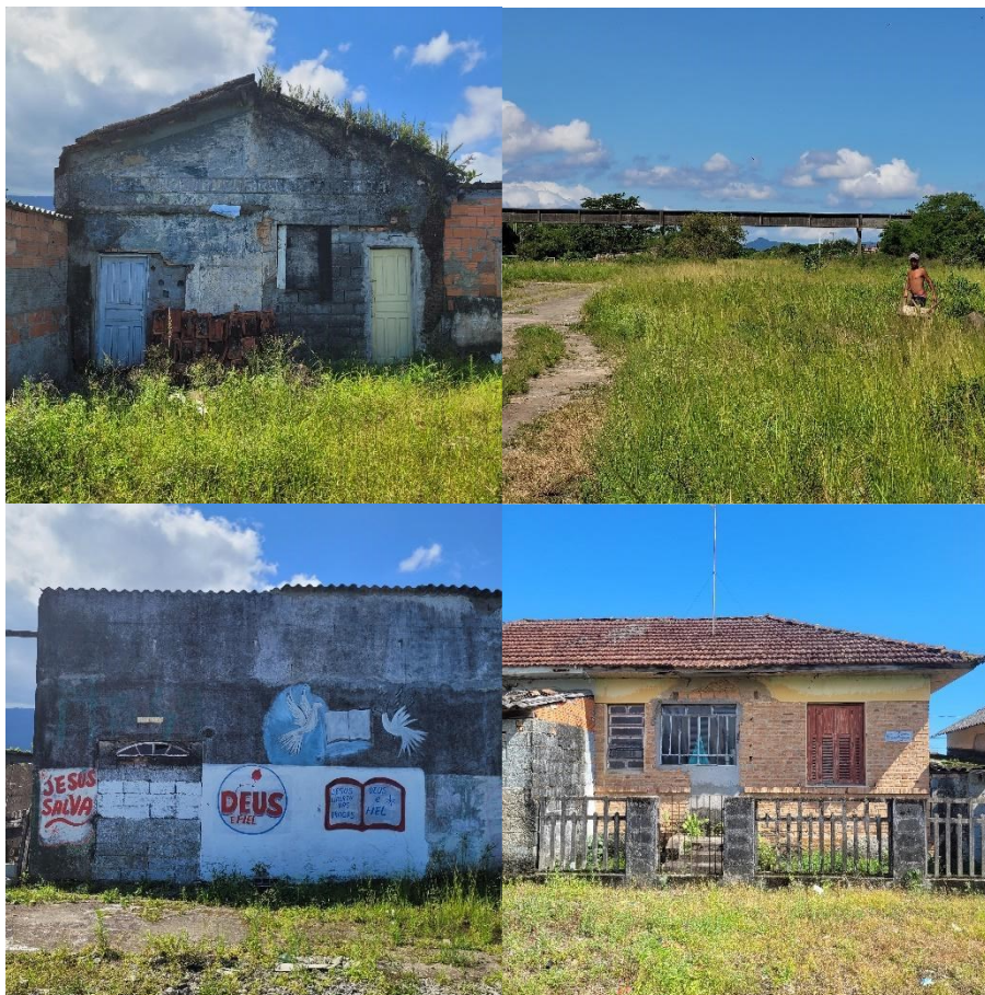
Figura 62 – O posto de truqueiro sem o seu sofá vermelho e a janela basculante. O habitante que me observava enquanto trabalhava. As inscrições no posto de revisão de vagões. A fachada de uma das residências voltadas ao leito férreo
