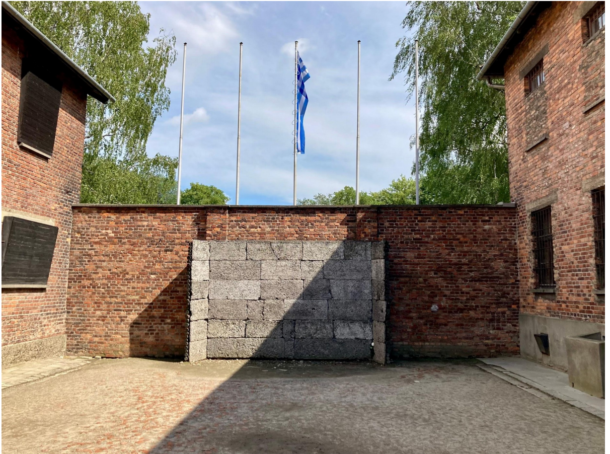
Figura 22: Muro da Morte
