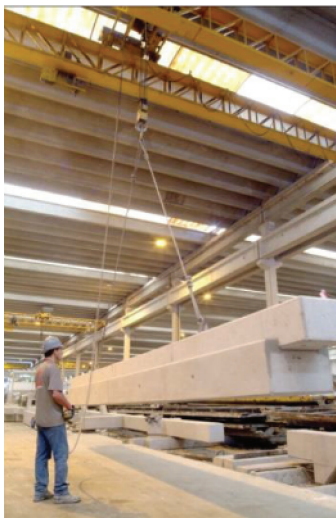
Figura 1 – Situações transitórias de projeto e fabricação – manuseio e içamento de viga pré-fabricada.
