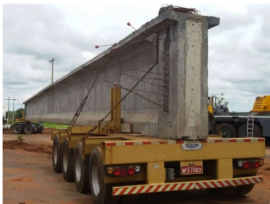
Figura 5 – Transporte de viga pré-moldada.
