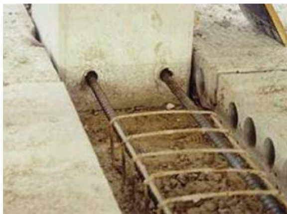
Figura 14 – Armadura de continuidade passando dentro do pilar
