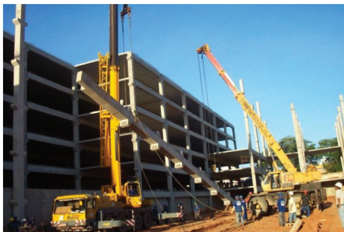
Figura 7 – Içamento de pilares pré-fabricados durante a montagem.
