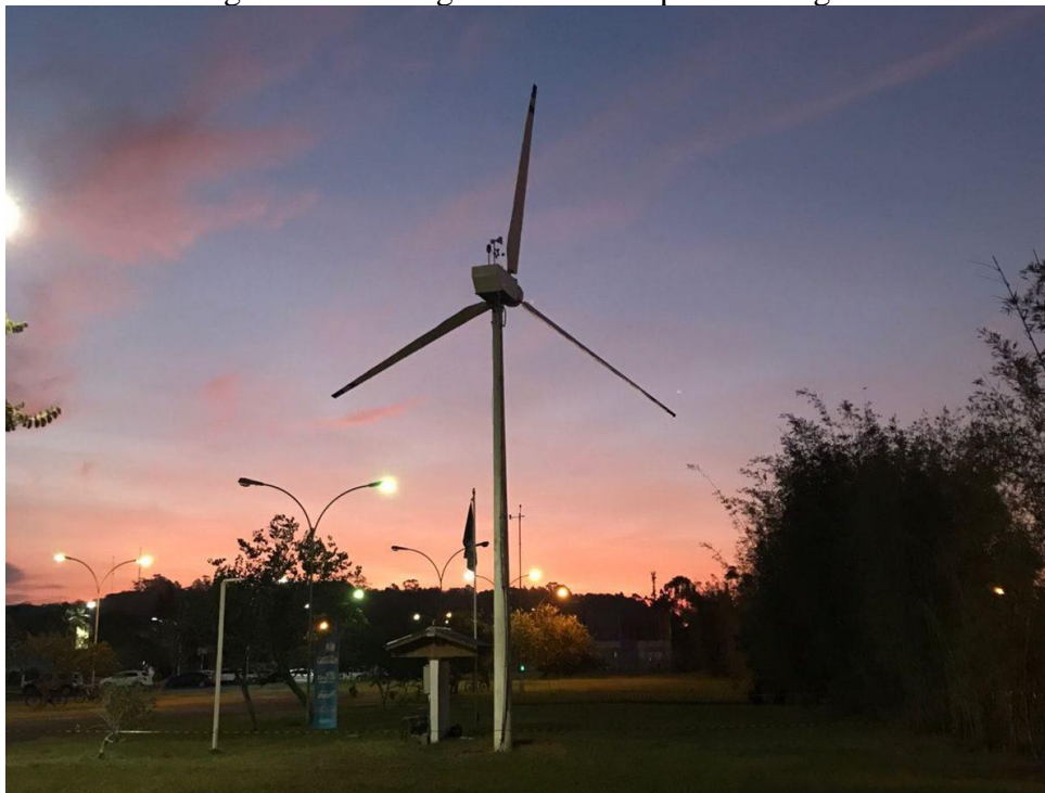
Figura 4.2 - Aerogerador do Campus Araranguá
