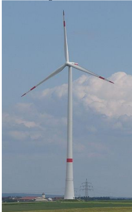
Figura 2.13 - Aerogerador moderno de três pás.
