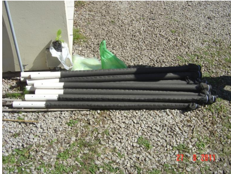
Figura 3. Tubos de PVC revestidos com geotêxtil antes da instalação. (Foto: Raphael Niero, 2011)
