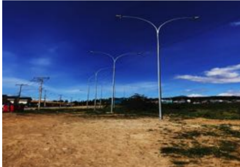
Figura 26 – Reforma de caminho peatonal utilizado pelos moradores
