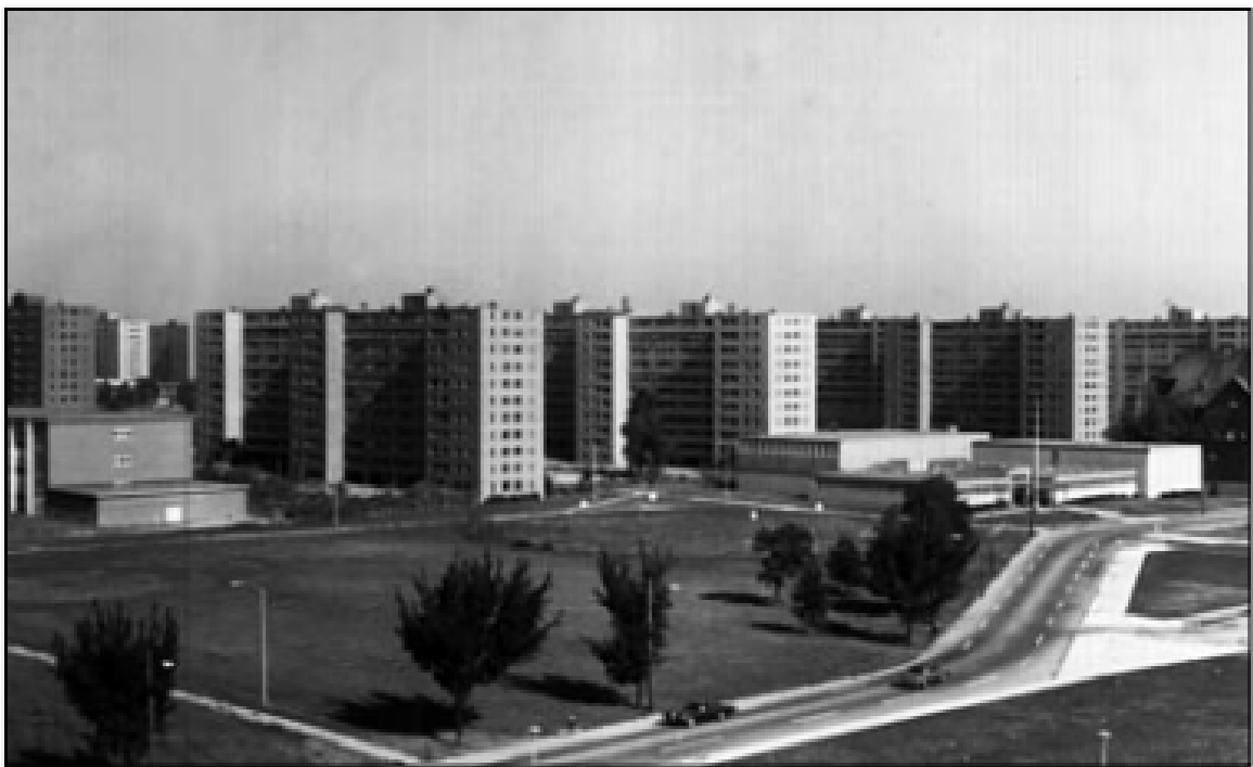
Figura 8 – Conjunto habitacional Pruitt - Igoe antes de sua demolição
