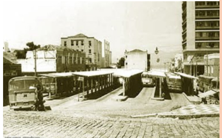
Figura 7 - Terminal de ônibus no antigo Largo da Carioca
