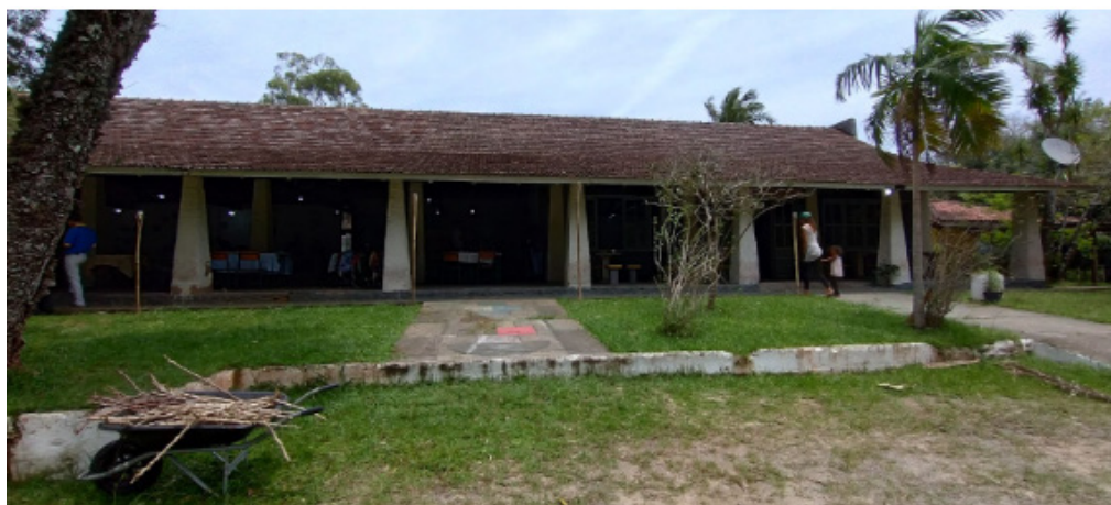
Figura 17 e 18 - Edificação principal do camping
