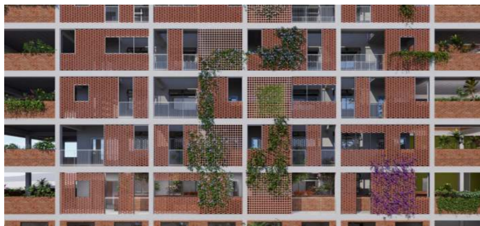
Fachadas dos brises do prédio
