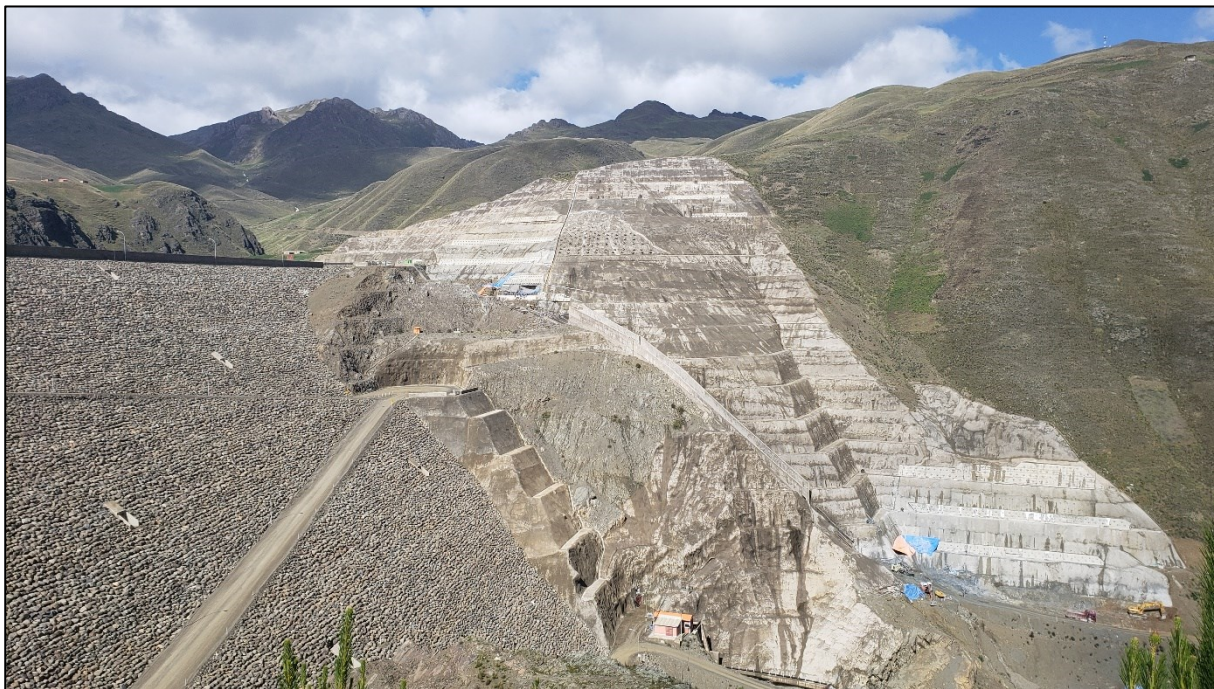
Figura 4.3. Vista geral da Barragem Misicuni e do talude de escavação do vertedouro (Fonte: Nova Engevix Engenharia e Projetos S/A).
