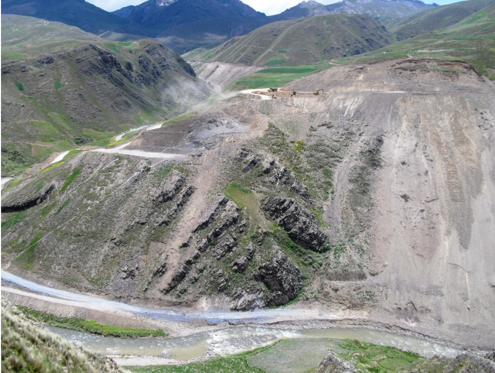
Figura 4.10. Vista geral da localização da margem esquerda. Início das escavações para implementação do vertedouro e barragem.
