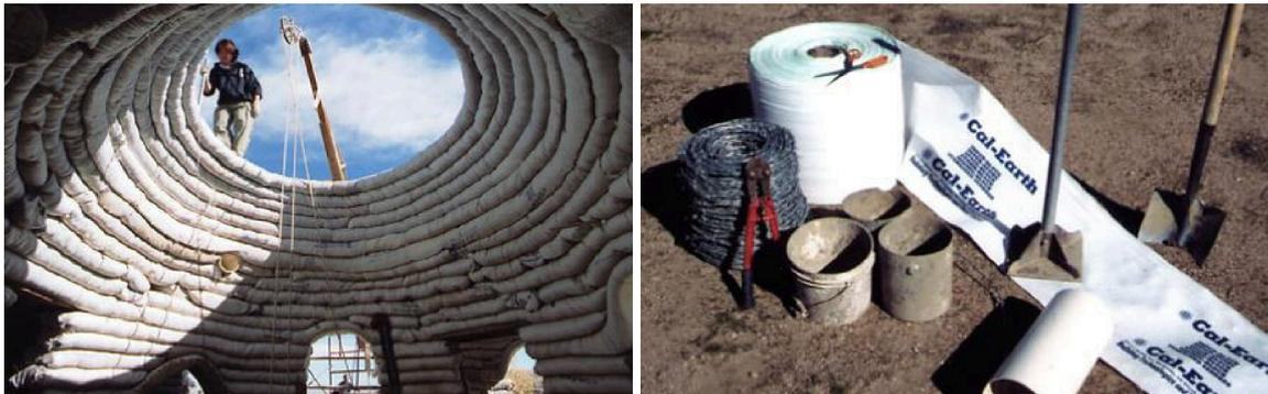
Figura 07 – Construção do abrigo com a técnica de “SuperAdobe”: (a) Vista do interior de quando o processo de construção e disposição das camas; (b) materiais utilizados na sua construção. Fonte: CalEarth (2017).
