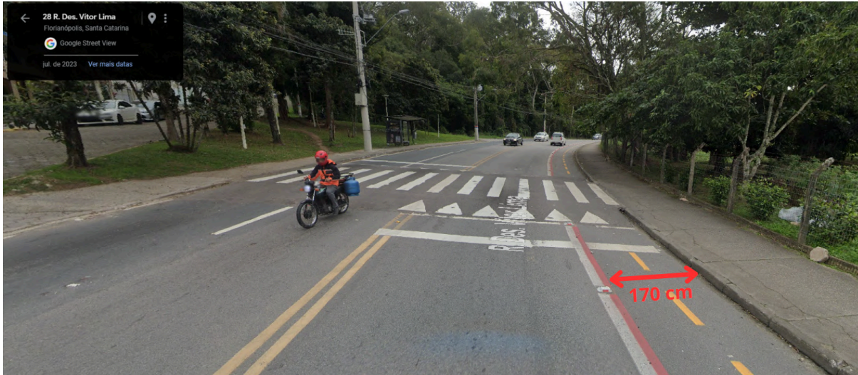
Figura 69 - Largura útil mínima insuficiente na Rua Desembargador Vitor Lima (Trindade)
