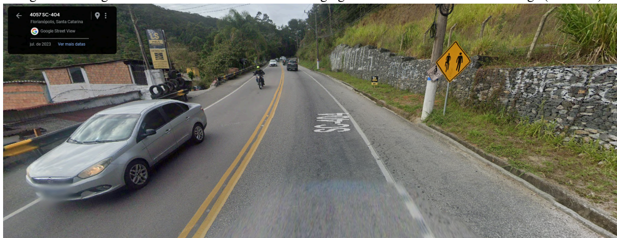
Figura 71 - Largura insuficiente e falta de elementos segregadores na Rodovia Admar Gonzaga (Itacorubi)
