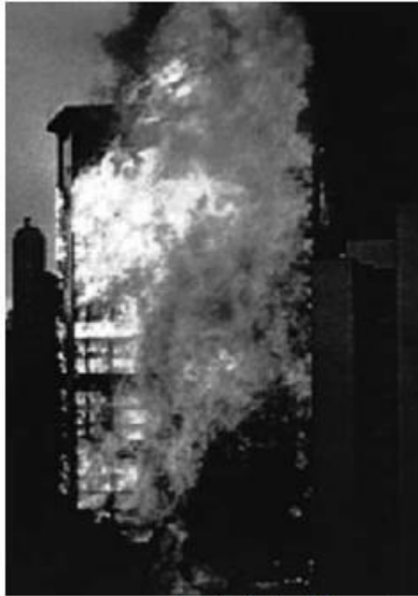
Figura 01 – Incêndio no Edifício Andraus
