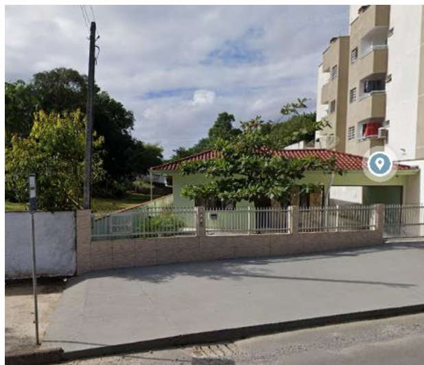
Figura 37 – Imóvel na Rua Santa Catarina nº5001
