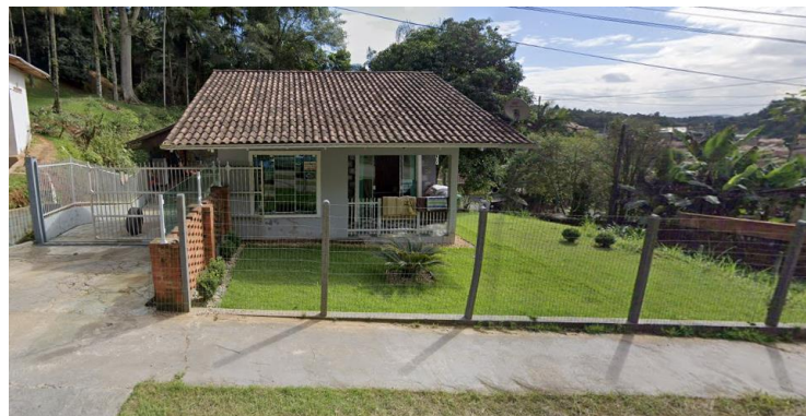
Figura 34 – Imóvel na Rua Santa Catarina nº4634
