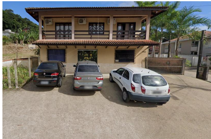
Figura 36 – Imóvel na Rua Santa Catarina nº4982
