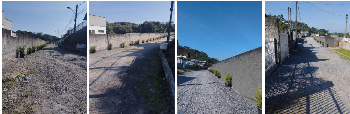
Figura 26 – Muramento Atual e Via de Acesso
